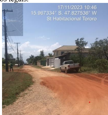
Foto 3. Solo exposto e via não pavimentada em condomínio onde moradores se queixavam de constantes alagamentos devido à ausência de sistema drenagem pluvial (ARINE). Moradora questionou a aprovação da drenagem pela NOVACAP e o indeferimento pelo IBRAM.
