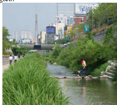
f) Renaturalização de curso hídrico na Coreia do Sul com estrutura para facilitar mobilidade de pedestre, próximo a parada de ônibus e estação de metrô.
