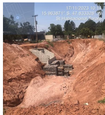
Foto 2. Bacia de contenção em construção para implantação do sistema de drenagem pluvial em condomínio de alta renda já consolidado.
