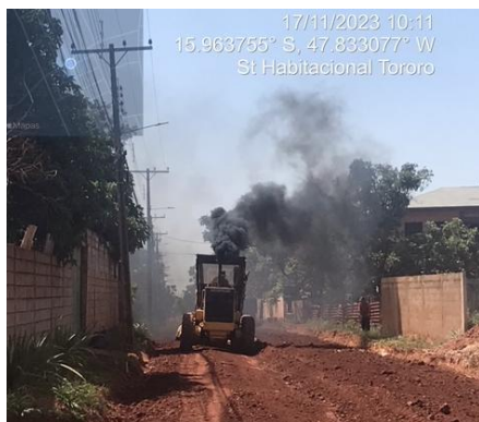
Foto 1. Maquinário utilizado para implantação de vias internas em condomínio de alta renda com emissões de poluentes atmosféricos visivelmente fora dos parâmetros legais.
