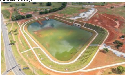
Foto 13. Bacia de retenção de escoamento pluvial superficial multifuncional no Plano Piloto (Drenar DF) integrada à parque com infraestrutura urbana (ciclovias, estacionamento, calçada com pedras portuguesas, bancos em formato de pentágono, paraciclos, lixeiras, jardinagem, espaço para food truck...).
