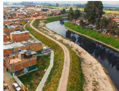
l) Recuperação de rio em Bogotá, melhorando qualidade da água, reduzindo risco de inundações e criando espaço multifuncional.
