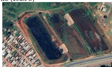
Foto 14. Bacias de retenção de escoamento pluvial superficial no Sol Nascente (ARIS) sem integração com tecido urbano e sem paisagismo com uso de métodos construtivos multifuncionais.
