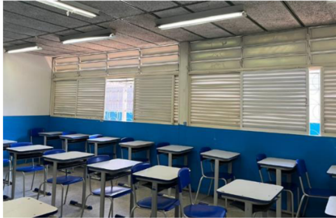
Figura 2. Uma das salas de aula da escola.
