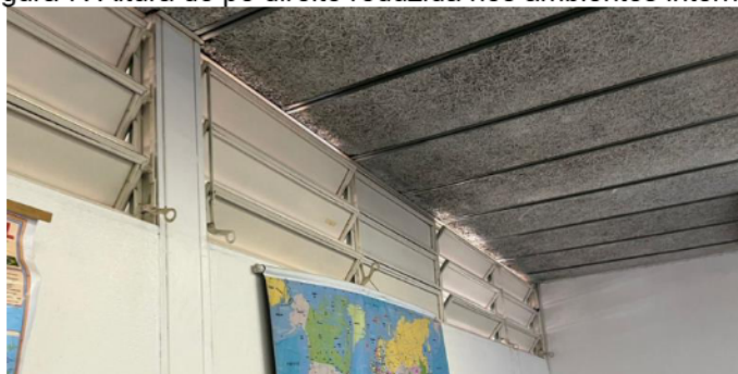
Figura 7. Altura do pé direito reduzida nos ambientes internos.
