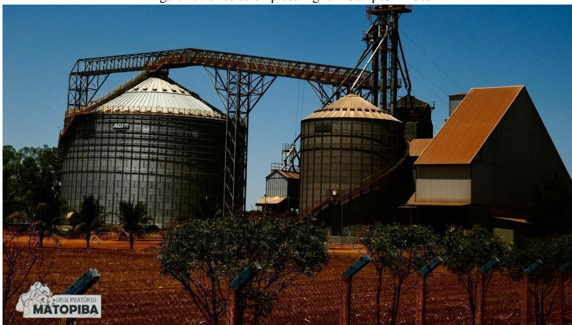
Figura 19: Silos da empresa Agi em Campos Lindos
