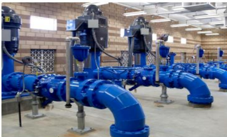
Figura 2.17 - Estação de bombeamento instrumentada. Fonte: https://www.abstelemetry.com/saneamento
