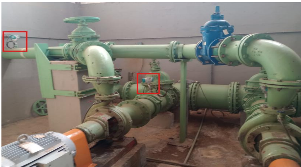
Figura 3.2 – Instrumentação no barrilete de recalque. Fonte: Relatório de visita técnica ao sistema.
