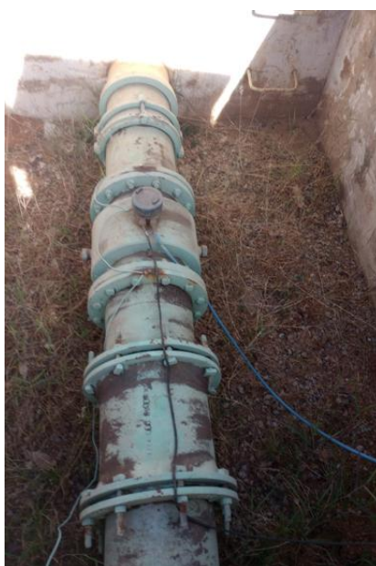
Figura 3.3 - Instrumentação na linha de distribuição. Fonte Relatório de visita técnica ao sistema.
