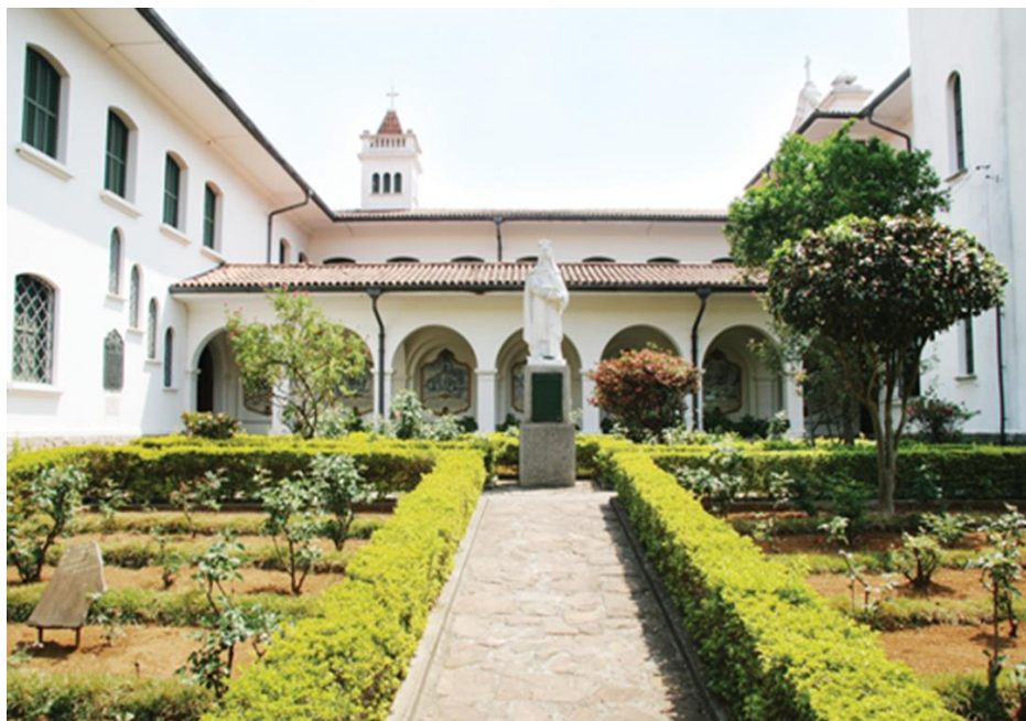
Figura 5. JORNAL ZONA SUL. Mosteiro de Santa Teresa. Disponível em: https://jornalzonasul.com.br/tombamento-de-mosteiro-esta-parado-ha-dez-anos/ . Acesso em: 01 out. 2024.
