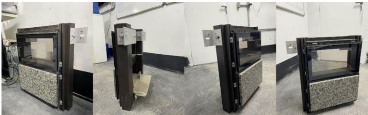
Figura 17 - Modelo padrão para os módulos da fachada unitizada feito no canteiro de obras.
