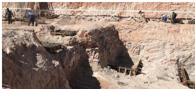
Figura 12 - Presença de rocha arenita no terreno do edifício avaliado.
