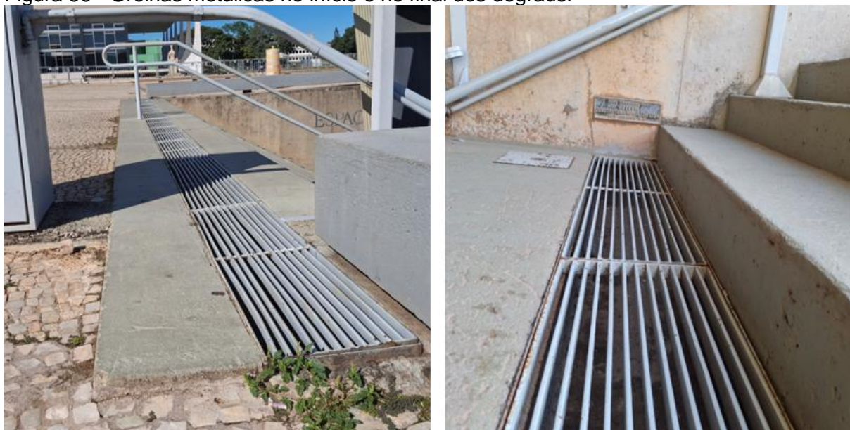
Figura 56 - Grelhas metálicas no início e no final dos degraus.
