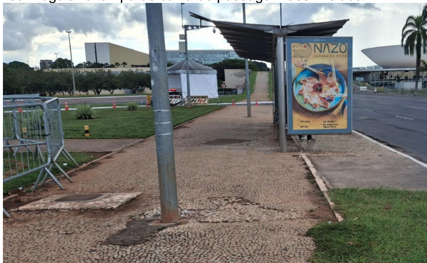
Figura 93 - Piso irregular e tampa de caixa de passagem desnivelada.
