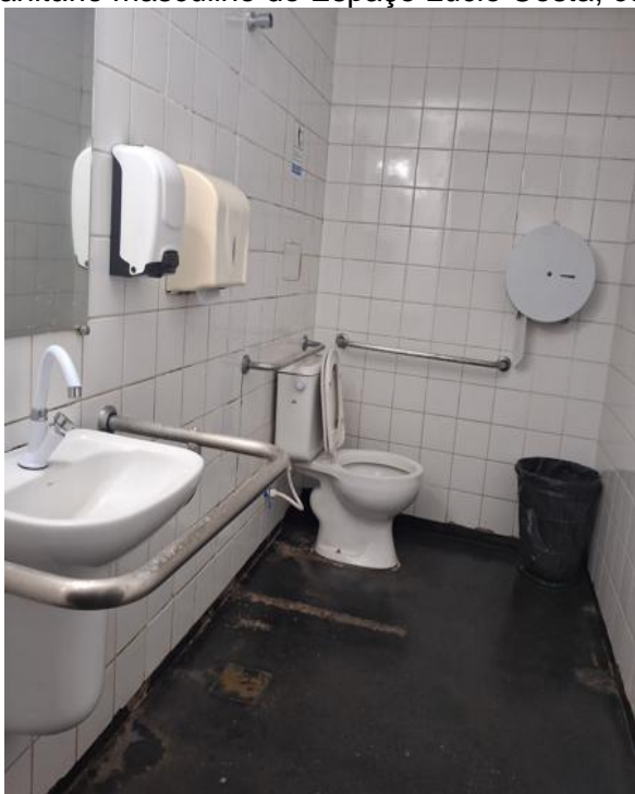
Figura 66 - Interior do sanitário masculino do Espaço Lucio Costa, com barras de apoio.
