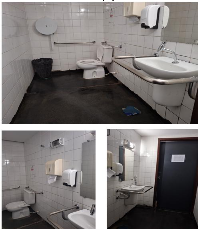
Figura 65 – Interior do sanitário feminino do Espaço Lucio Costa, com barras de apoio.
