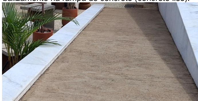
Figura 70 - Guia de balizamento na rampa de concreto (concreto liso).
