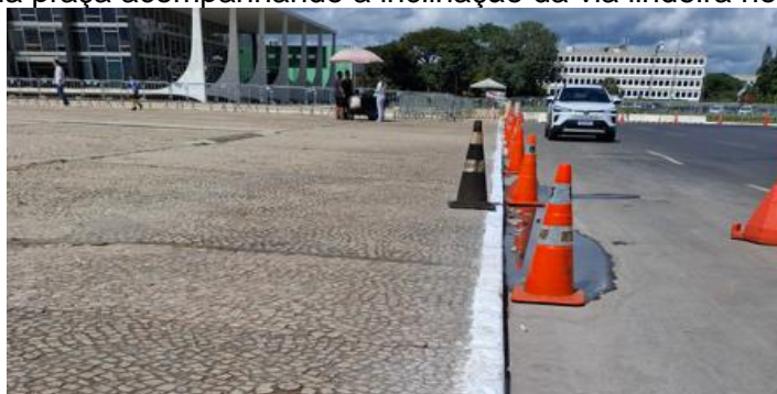
Figura 104 - Piso da praça acompanhando a inclinação da via lindeira no Trecho 2.
