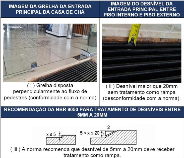
Figura 68 - Desnível e grelha metálica na entrada principal /recomendação da norma.
