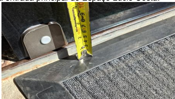
Figura 57 - Desnível na entrada principal do Espaço Lucio Costa.
