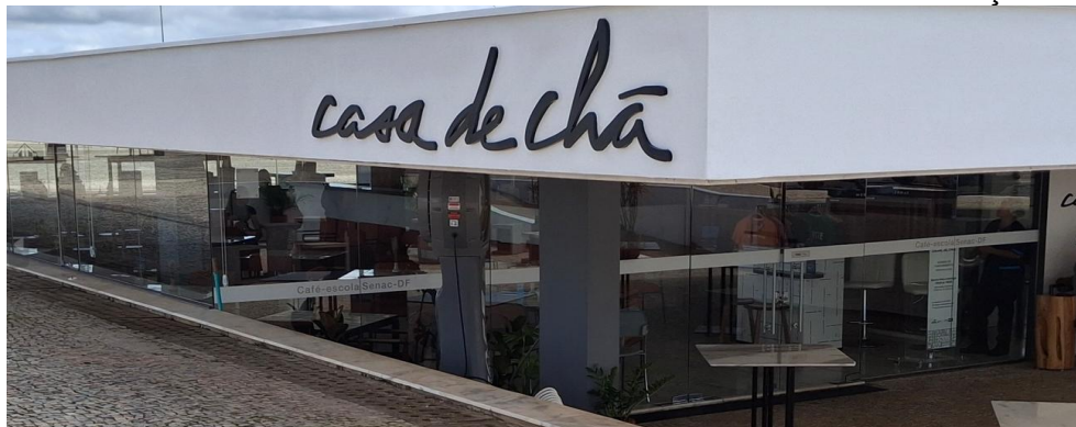
Figura 78 - Portas de entrada da Casa de Chá em vidro com faixa de sinalização.
