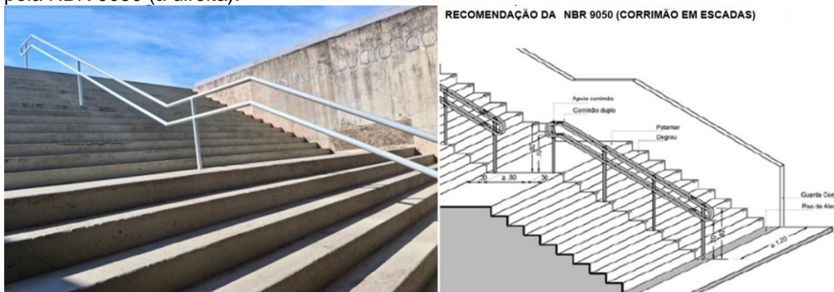
Figura 59 - Corrimão da escada do Espaço Lucio Costa (à esquerda) e corrimão recomendado pela NBR 9050 (à direita).
