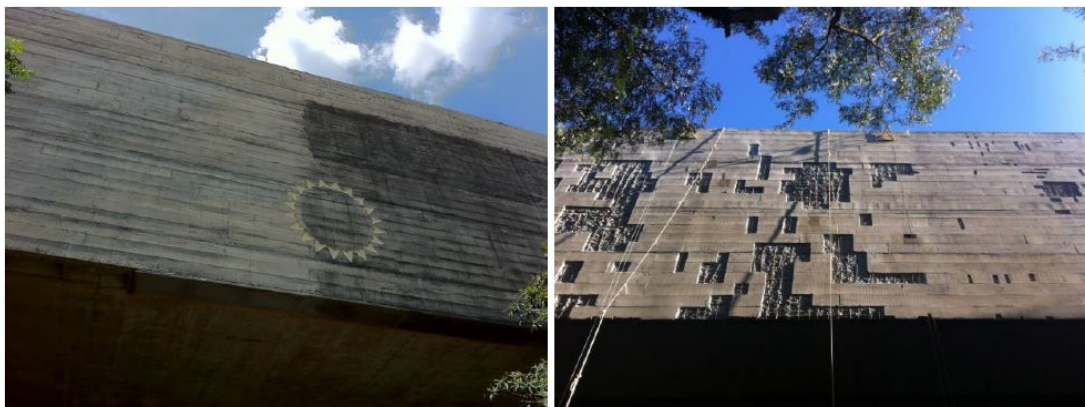
Figura 1 – Limpeza por hidrojateamento e escarificação da empena de concreto Fonte: Castro et al. (2016).
