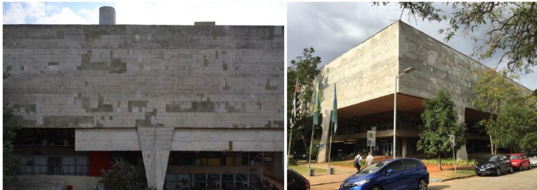
Figura 2 – Execução de intervenção na empena com alterações na coloração original do concreto Fonte: Castro et al. (2016).
