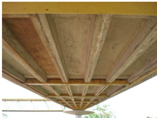
Figura 4.4 – Detalhes das Placas de Piso da Passarela sobre a E.P.I.A, vista inferior
