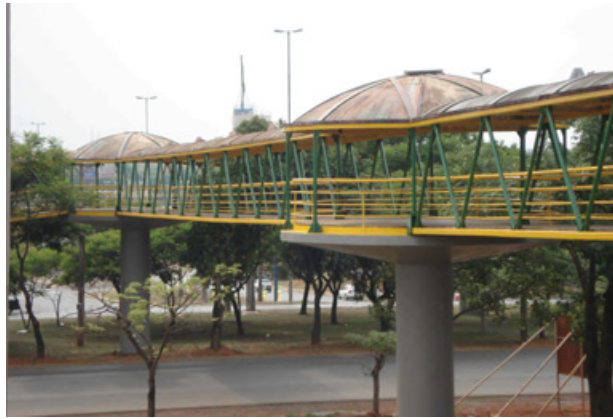
Figura 4.2 – Vista dos Cogumelos da passarela sobre a E.P.I.A
