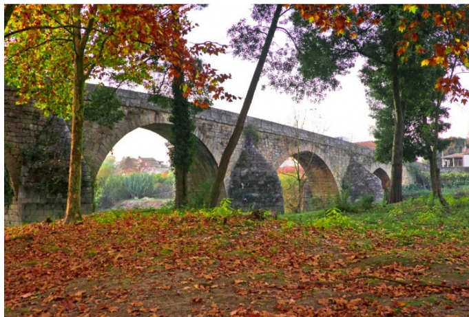
Figura 2.10 – Ponte da Lagoncinha sobre o Rio Ave, Vila Nova de Famalicão, Portugal.
