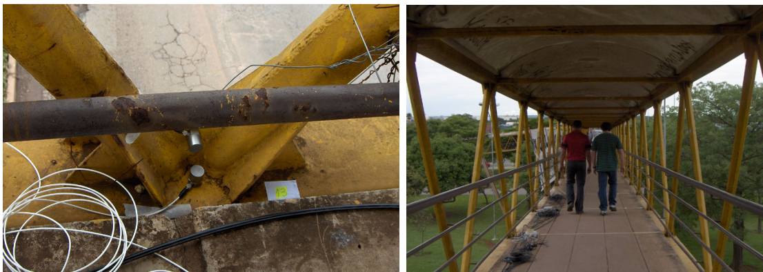
Figura 2.5 – Detalhe da posição dos acelerômetros Brasileiro et al.(2008)
