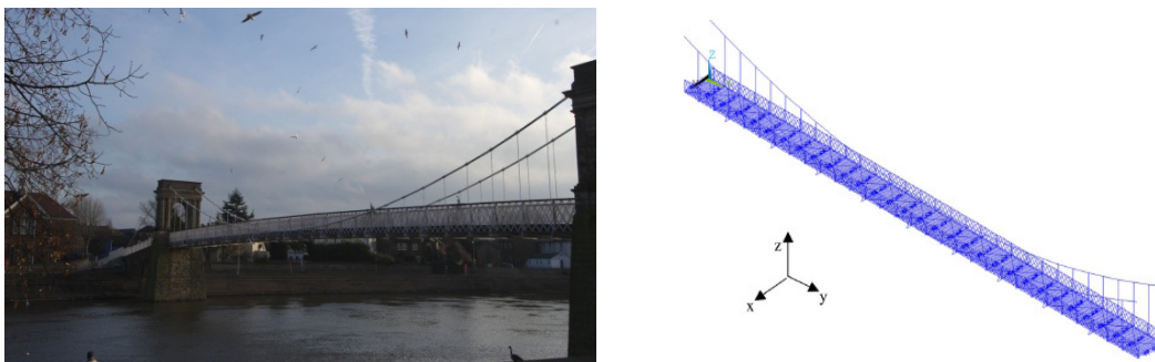
Figura 2.15 – Passarela em Nottingham à esquerda e o modelo de EF à direita
