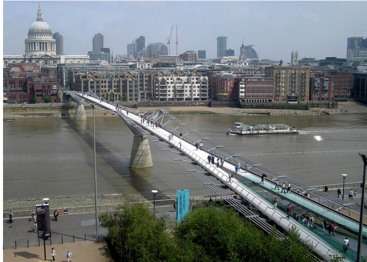
Figura 1.1 – Passarela Millenium Bridge sobre o rio Tamisa Londres
