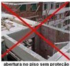
abertura no piso sem proteção
