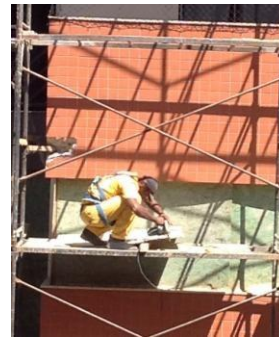
Operário Trabalhando no 2º andar Serrando madeira para montagem do andaime
