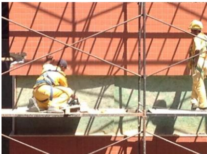
Operário 1 Trabalhando no 2º andar Serrando madeira para montagem do andaime e Operário 2 Observando, aguardando comando (Ajudante)
