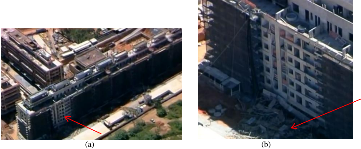
Figura 6.3 – Acidente com Andaime fachadeiro de obra (desmoronamento dia 30.04.2013, véspera do feriado do dia do trabalho).
