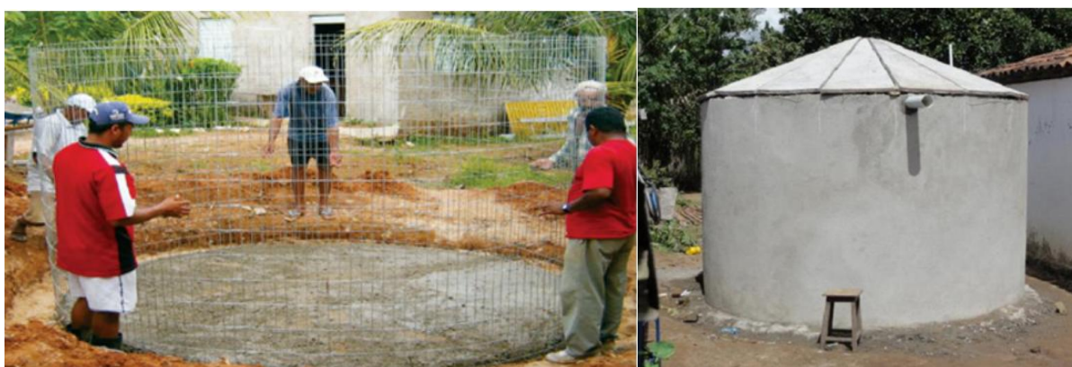
Figura 3: Cisterna Ferro cimento.
