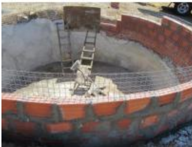
Figura 6-Cisterna de Tijolos
