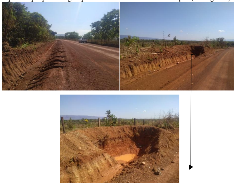
Figura 19- Exemplo de valeta na zona rural de Formosa-GO como estrutura de contenção de enxurradas para captação da água pluvial até uma bacia de retenção (barraginha)
