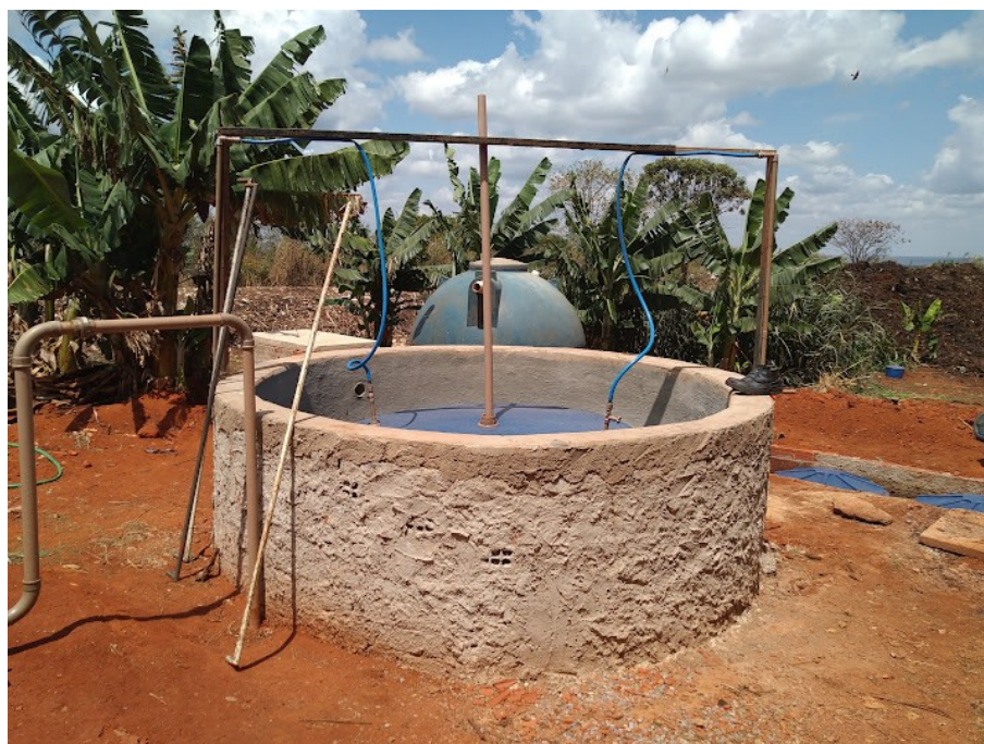
Anexo 3. Planta do projeto e imagem do sistema de tratamento aeróbio do lixiviado gerado no processo de compostagem, incluindo o gasômetro para biogás.
