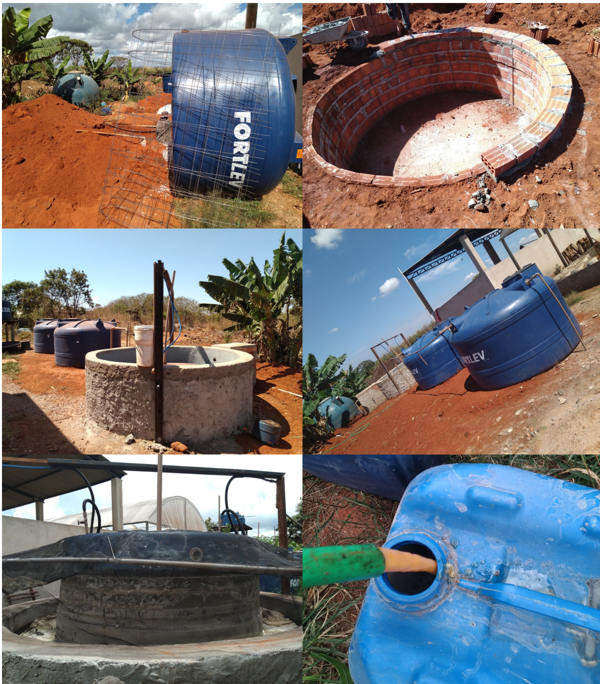
Anexo 4. Imagens da construção e do funcionamento do sistema de tratamento do lixiviado gerado no processo de compostagem.
