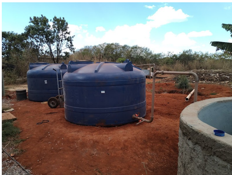
Anexo 2. Planta do projeto e imagem do sistema de tratamento anaeróbio do lixiviado gerado no processo de compostagem.
