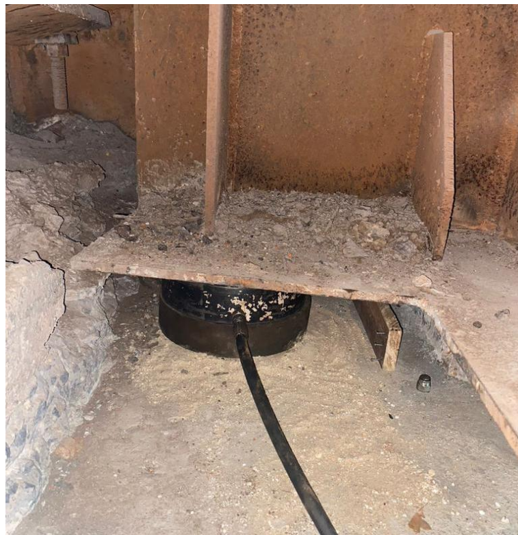
Figura 50 - Detalhe de um dos aparelhos de apoio na ponte sendo substituído
