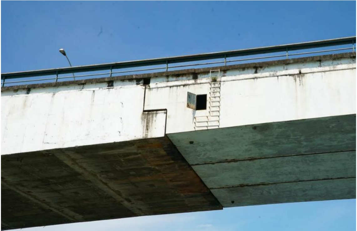
Figura 39 - Alçapão de acesso ao vão central metálico
