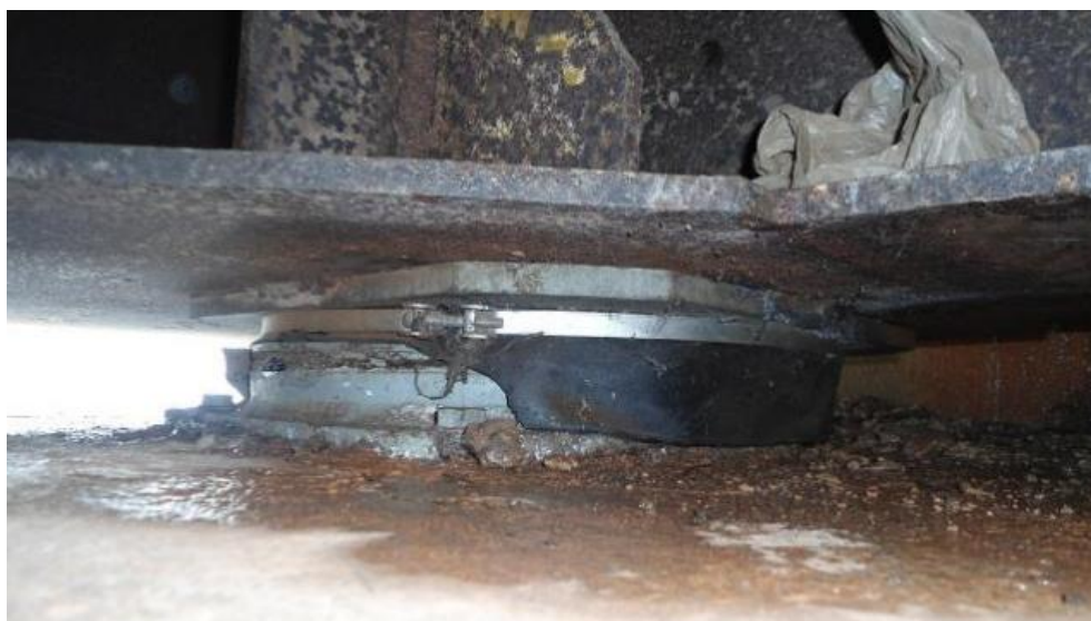
Figura 48 - Aparelho de apoio do vão central antes da reforma
