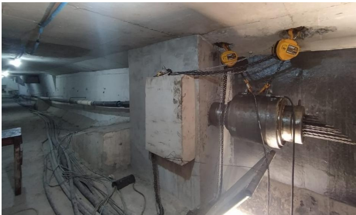
Figura 35 – Instalação da protensão externa fixada na alma do tabuleiro da ponte
