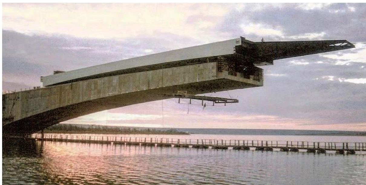
Figura 24 - Deslocamento do tabuleiro metálico para implantação no vão central da Ponte Honestino Guimarães
