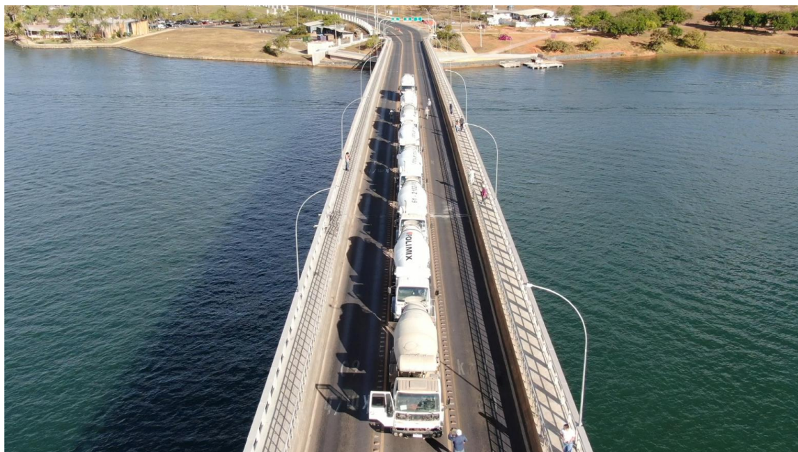
Figura 77 – Vista aérea do Arranjo A2 da prova de carga realizada pela empresa LSE
