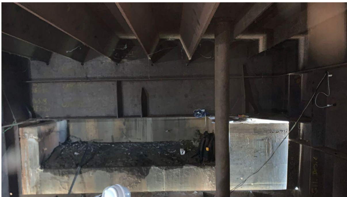
Figura 41 – Apoio do tabuleiro metálico sobre o arco de concreto protendido da margem do Lago Sul
