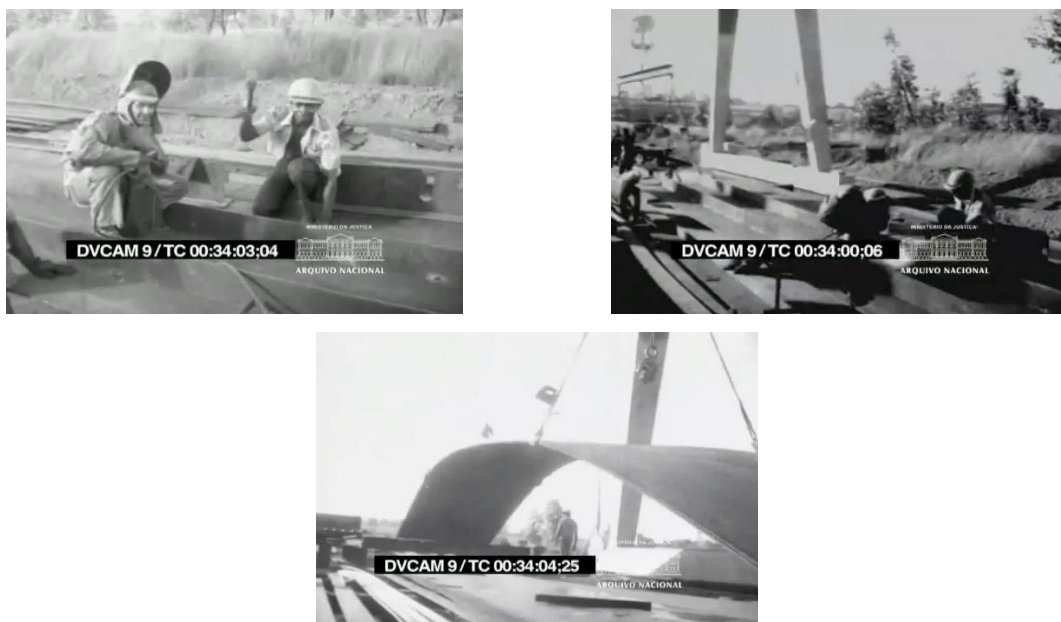
Figura 22 – Construção metálica soldada do vão central metálico em canteiro de obras
