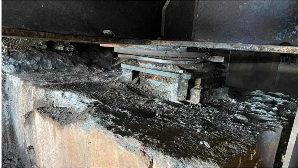
Figura 49 - Aparelho de apoio do vão central durante a reforma
