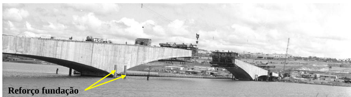
Figura 23 – Ponte Honestino Guimarães antes da implantação do tabuleiro metálico ortotrópico, em 1975
