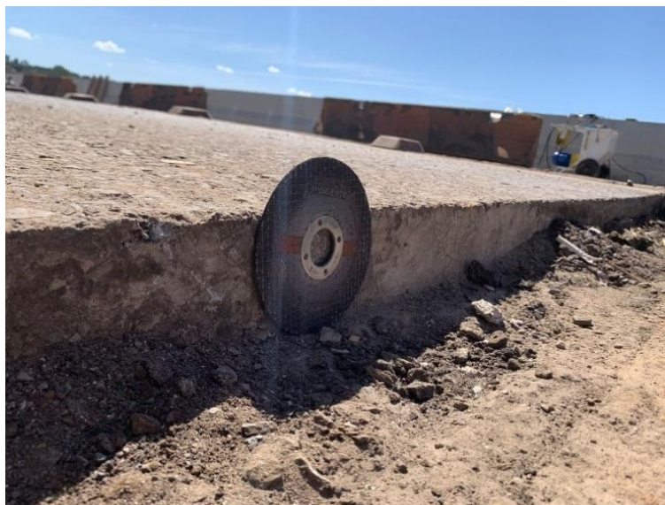
Figura 57 - Laje de concreto sobre o tabuleiro metálico da ponte, em comparação a um disco de serra circular
