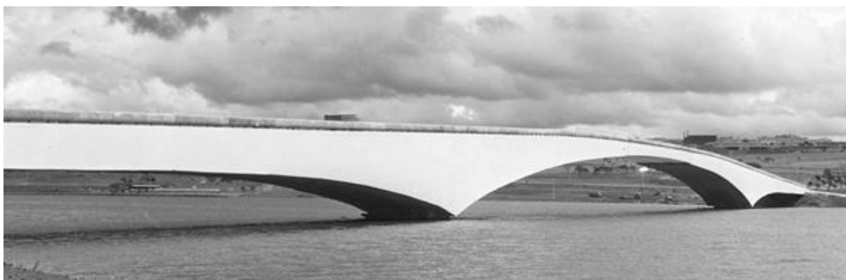
Figura 26 – Ponte Honestino Guimarães após a implantação do tabuleio metálico ortotrópico, em 1976
