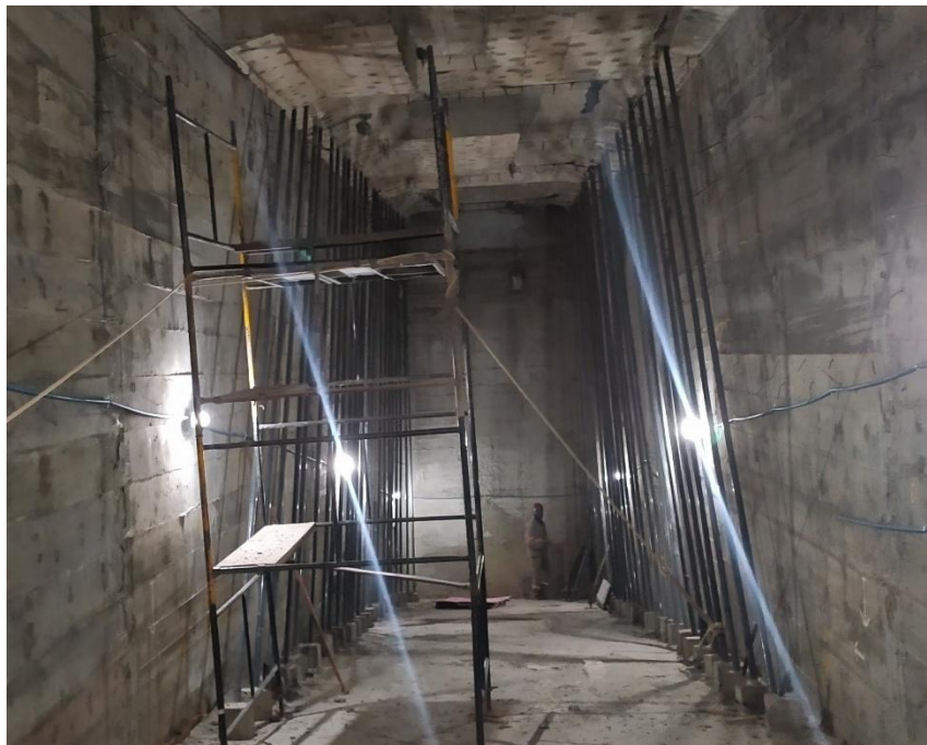
Figura 20 - Reforço com uso de protensão externa na região dos apoios centrais
