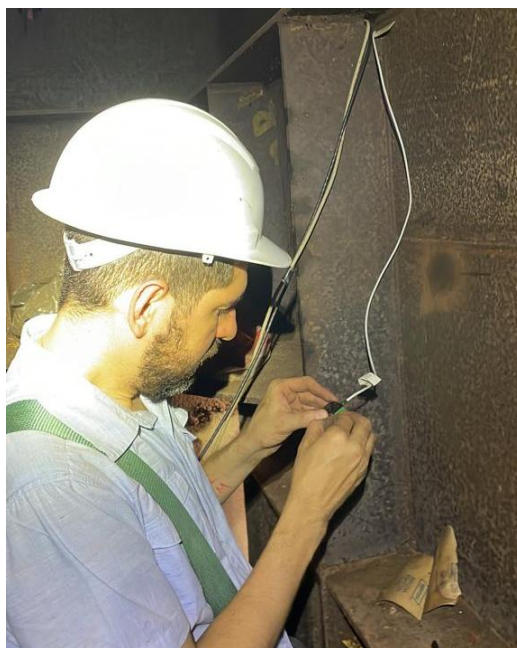
Figura 73 - Registro da fixação dos acelerômetros na alma do tabuleiro metálico
