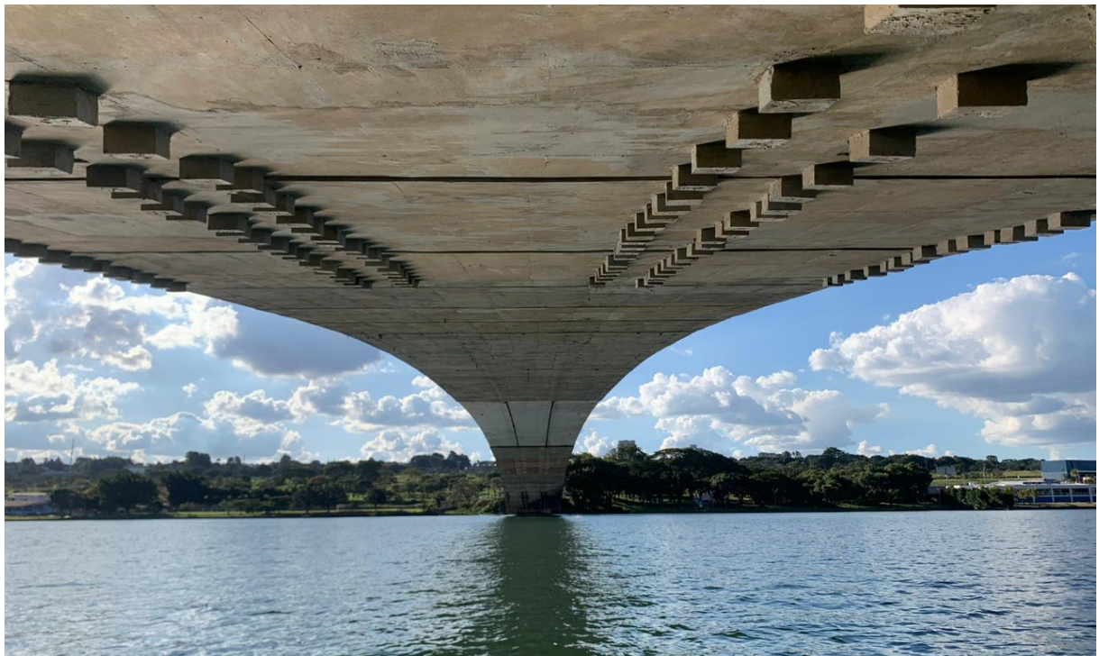
Figura 38 – Vista panorâmica inferior do arco em concreto protendido. Detalhe para o reforço vertical na região do apoio central da margem do Lago Sul
