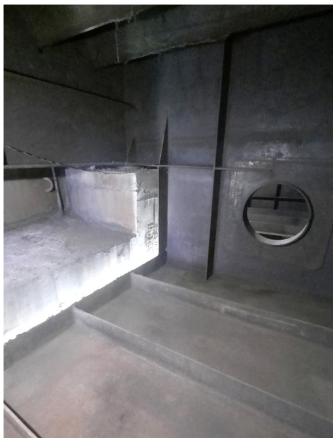
Figura 42 – Detalhe do apoio tabuleiro sobre o Dente Gerber do arco em concreto protendido
