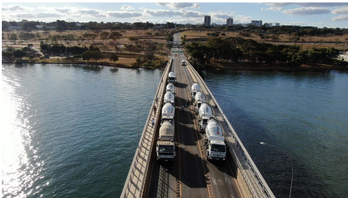
Figura 79 – Vista aérea do Arranjo A2 da prova de carga realizada pela empresa LSE
