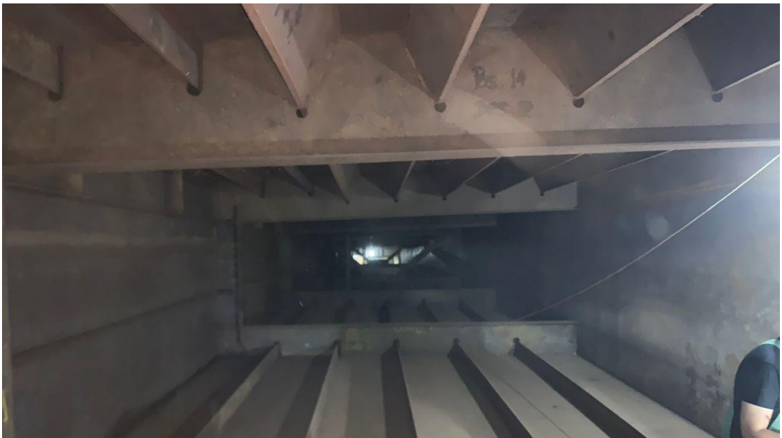
Figura 40 - Interior do tabuleiro metálico com visualização ao longo da direção longitudinal
