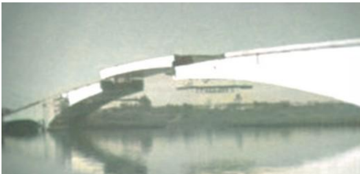
Figura 25 - Implantação do tabuleiro metálico de 58 m no vão central da Ponte Honestino Guimarães, em 1976
