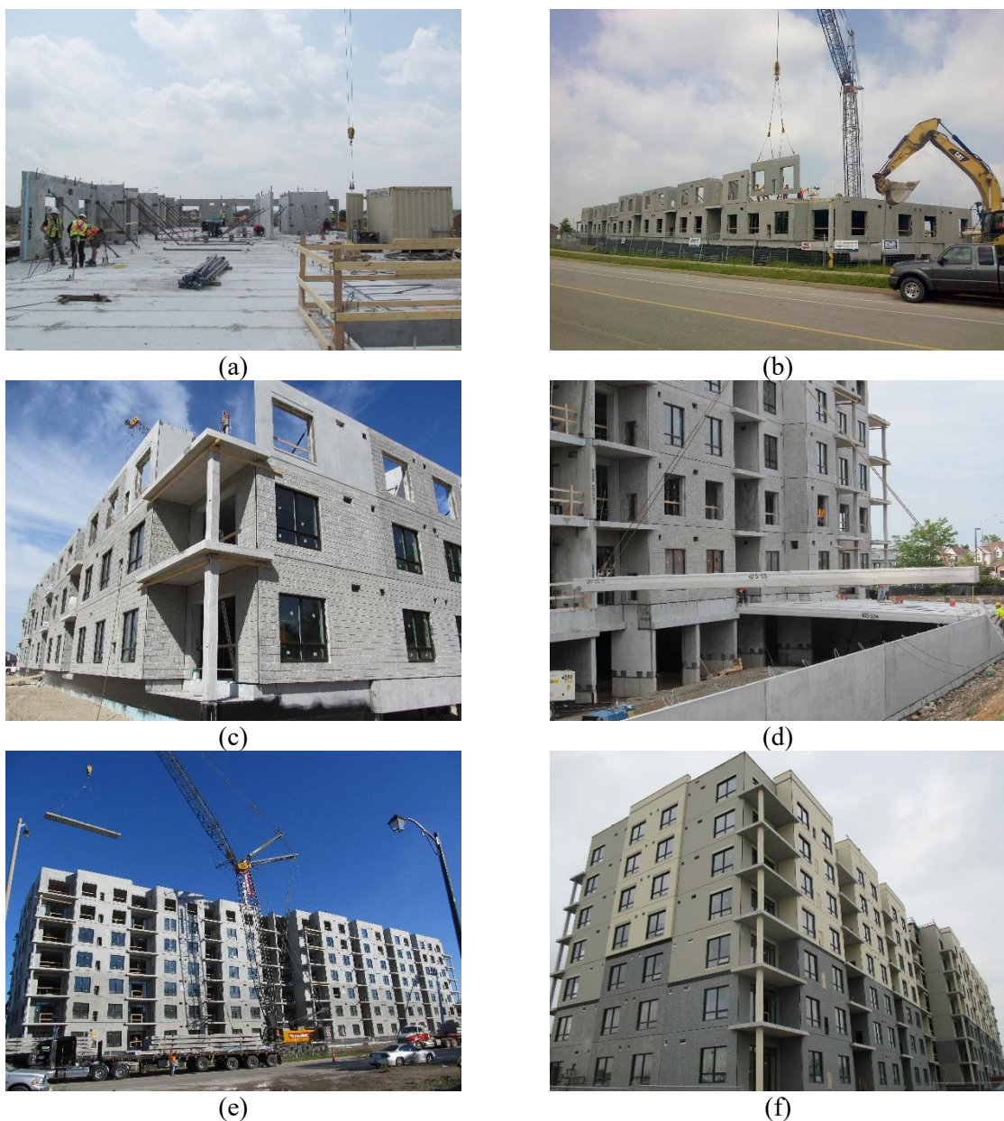
Figura 2.2 – Processo construtivo da obra Saginaw Gardens Apartment , no Canadá: (a) operários trabalhando sobre um pavimento; (b) içamento de um painel sanduíche; (c) montagem das paredes da fachada de um pavimento; (d) içamento de um elemento pré-moldado; (e) finalização do último
