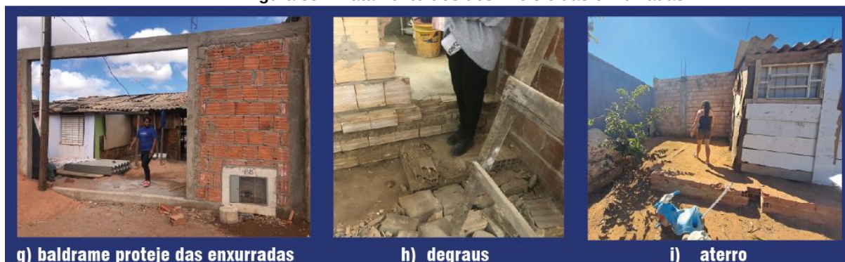
Figura 35 - Tratamento dos desníveis e das enxurradas
