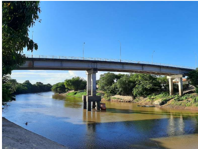
Figura 15 - Ponte Sobre o Rio Mearim (São Luís Gonzaga – MA)
