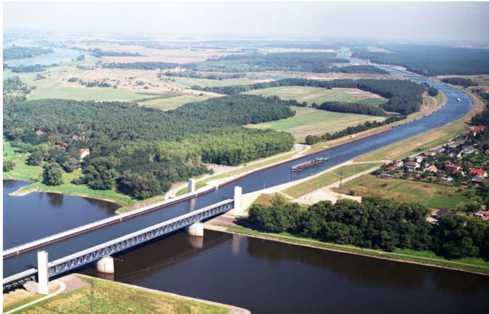
Figura 26 - canal sobre o Rio Elba (Alemanha)
