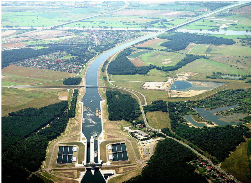
Figura 27 - canal sobre o Rio Elba (Alemanha)
