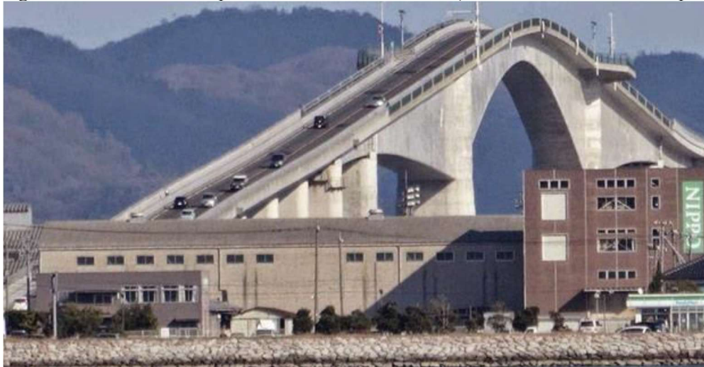
Figura 30 - Ponte em rampa e com tabuleiro convexo (Ponte Eshima Ohashi – Japão)
