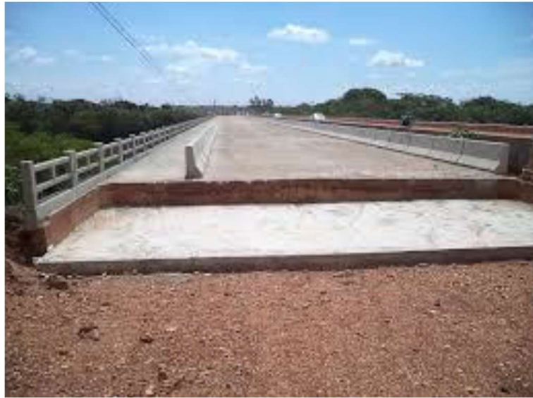
Figura 20 - Cortina extrema, alas e placas de transição
