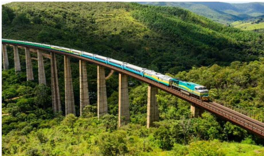
Figura 23 - Ponte ferroviária – Estrada de Ferro Vitória/Minas (Minas Gerais)
