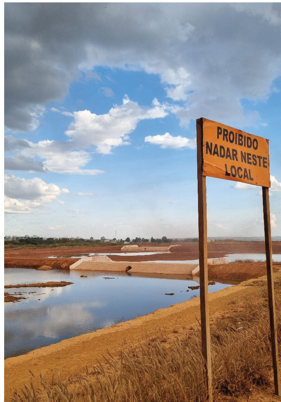
Figura 39: Situação de risco em bacia de contenção sem fechamento de proteção
