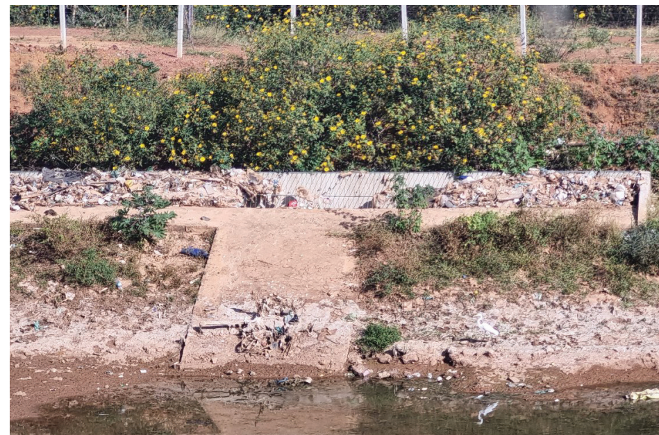
Figura 23: Falta de manutenção no vertedor de segurança para grandes cheias de bacia de contenção, Trecho II do Sol Nascente
