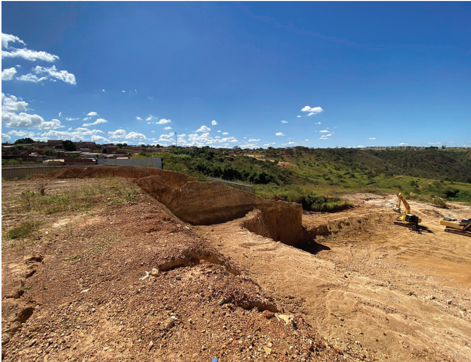
Figura 29: Bacia de retenção em fase de obras Fonte: Laboratório Periférico - Assessoria Sociotécnica, 2024 | Foto: Equipe Periférico
