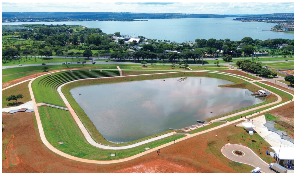
Figura 32: Bacia de retenção do sistema Drenar DF instalada na Asa Norte
