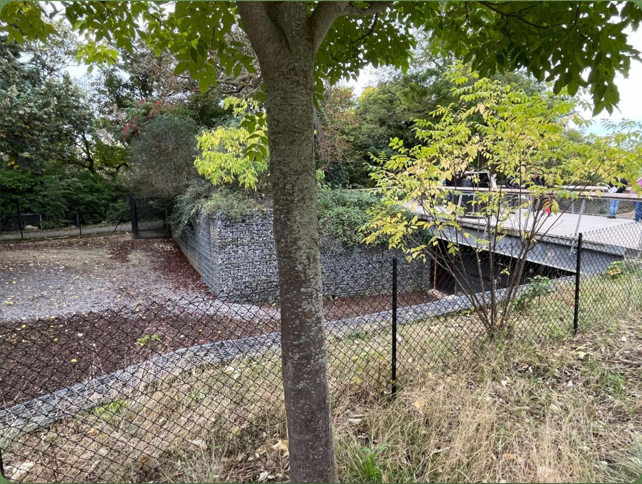
Figura 60 - Diferença de níveis com uso de gabião para contenção no Jardim Zoológico de Paris.
