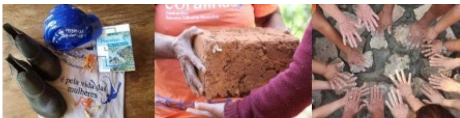
Figura 8 Fotos da construção da sede da Associação
