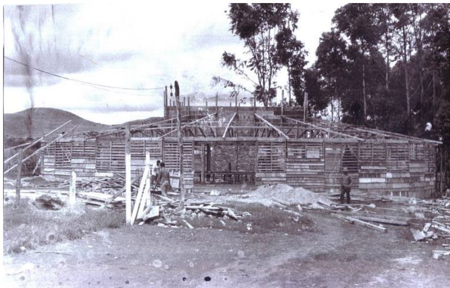
Figura 21: Primeiro templo religioso do Vale do Amanhecer em construção em 1971
