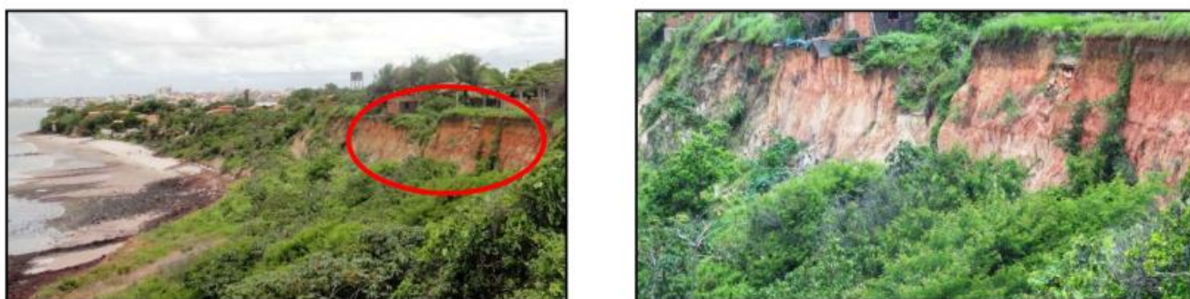
Figura 24. Processo erosivo nas proximidades da linha praia localizado na Bacia Hidrográfica do Bacanga.
