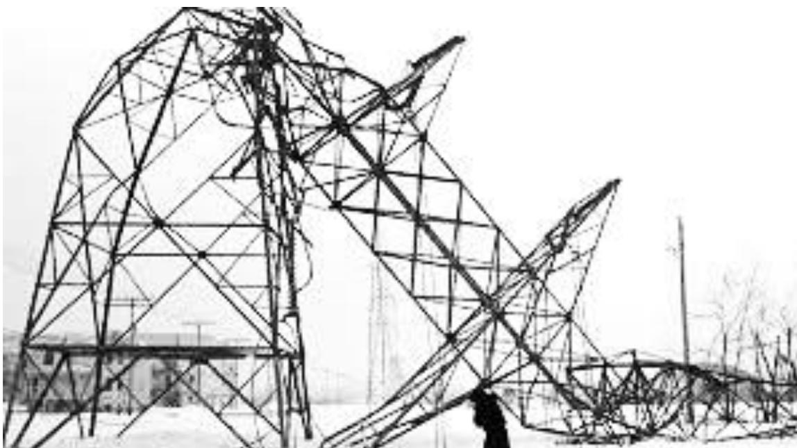
**Figura 2.2.3** - Falha típica de uma linha aérea causada por uma tempestade de gelo e um galope. Fonte: Li et al. (2021).
