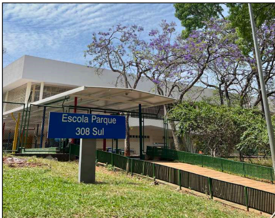
Figura 18 - Vista da entrada da Escola Parque da EQS 307/308
