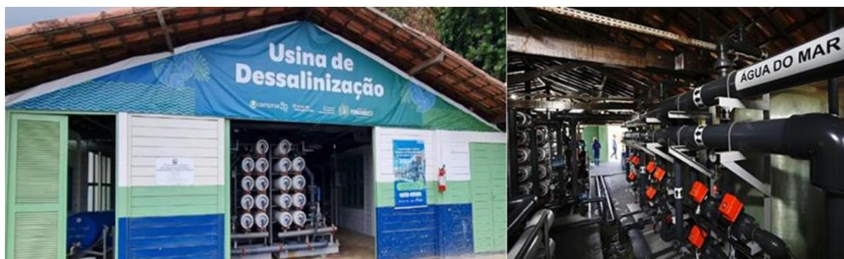
**Figura 2.6** - Usina de dessalinização por osmose reversa em Fernando de Noronha (PE), Fonte COMPESA.
