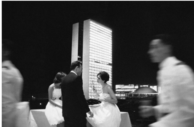
[ANEXO 6] Magnum Photos , Brasília, 1960. Noite da inauguração de Brasília. Edifício do Congresso Nacional planejado por Oscar Niemeyer. Brasília. Foto de René Burri. Acesso em < https://www.magnumphotos.com/arts-culture/architecture/rene-burri-brasilia-oscar-niemayer-architecture/ > maio de 2024.
