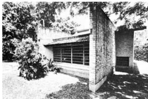
Figura 9: 1ª Residência João Vilanova Artigas, fachada do estúdio e dormitório, 1942 (Acayaba, 1985, p.42).
