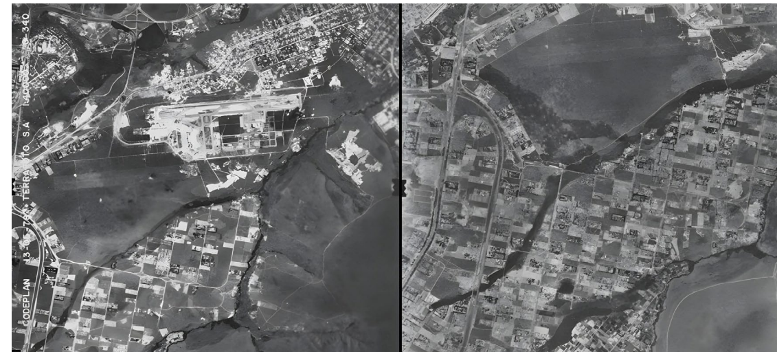
Figuras 17 e 18: Primeira imagem: loteamento do Setor de Mansões Park Way na década de 1970. Segunda imagem: loteamento do mesmo setor na década de 1990. Fonte: Secretaria de Desenvolvimento Urbano e Habitação do Distrito Federal, Governo do Distrito Federal. Acesso em: 6;08;2023 .
