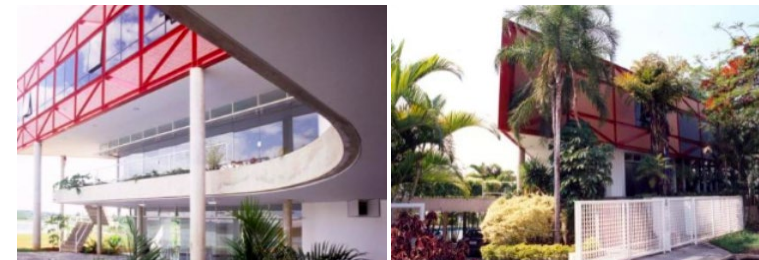
Figuras 1 e 2: Residência no Lago Sul QL 14, de Sérgio Parada.
