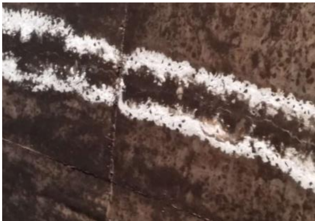
Figura 35 - Relatório 019: Laje inferior
