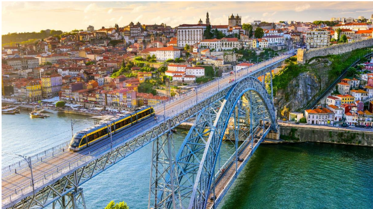
Figura 5 - Exemplo da ponte D. Luís I, localizada na cidade de Porto (Portugal)
