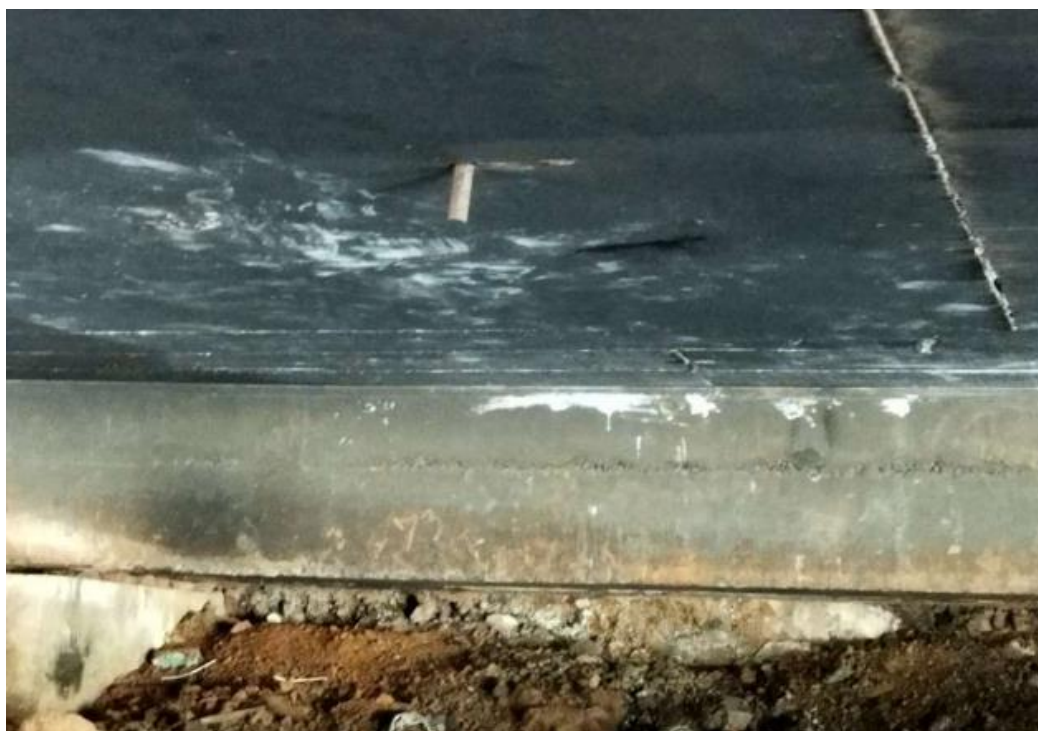
Figura 34 - Relatório 019: Viga travessa
