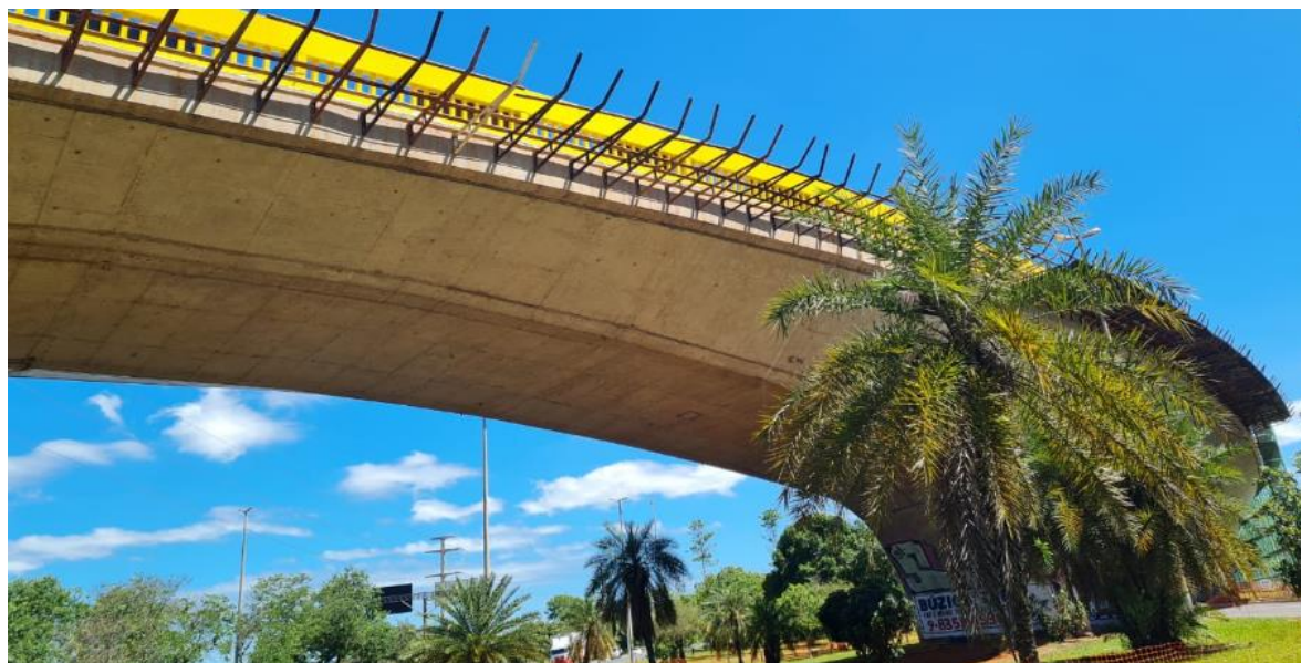
Figura 6 - Exemplo do viaduto Ayrton Senna, localizado na cidade de Brasília (Brasil)
