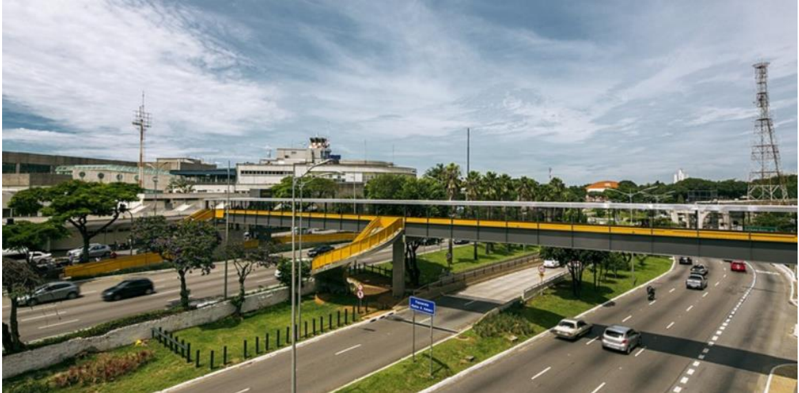
Figura 7 - Exemplo da passarela do aeroporto de Congonhas, localizada na cidade de São Paulo (Brasil)
