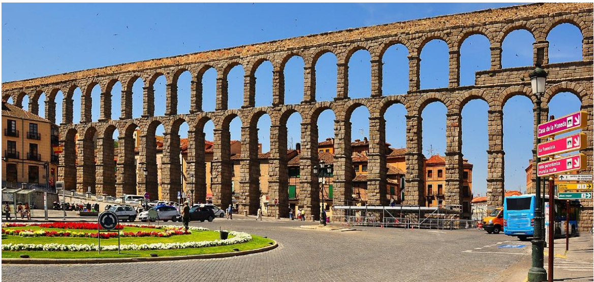
Figura 8 - Exemplo do aqueduto de Segóvia, localizada na cidade de Segovia (Espanha)
