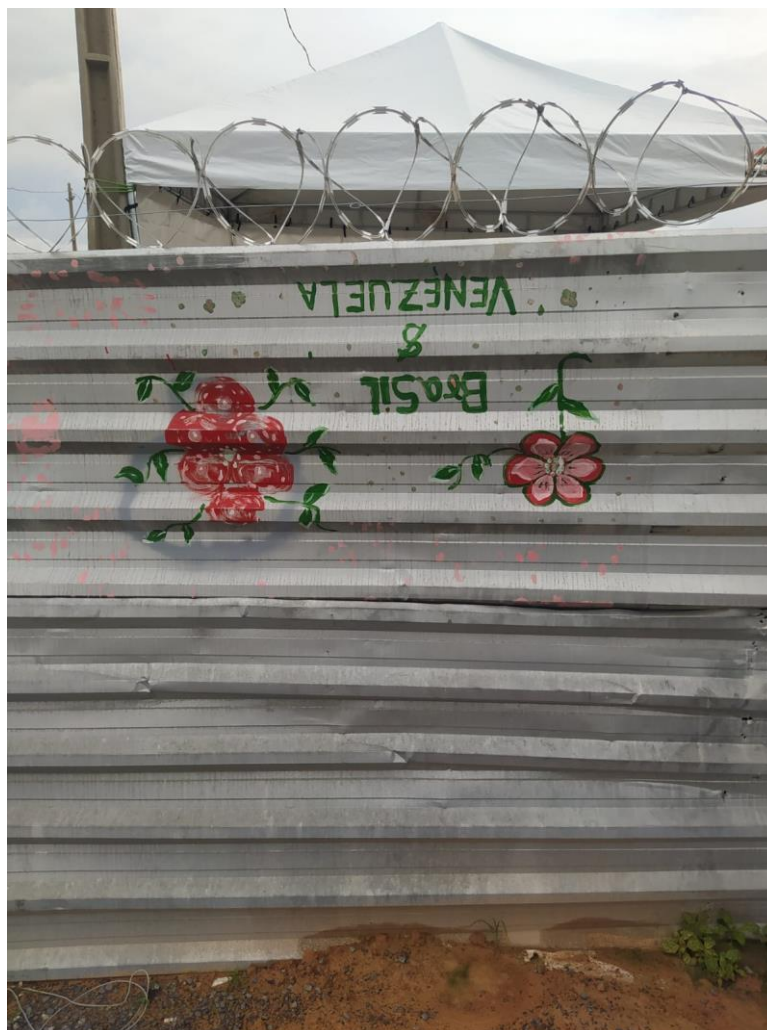
Imagem 18 – Muro na entrada do Abrigo Waraotuma a Tuaranoko (Fonte: acervo pessoal)
