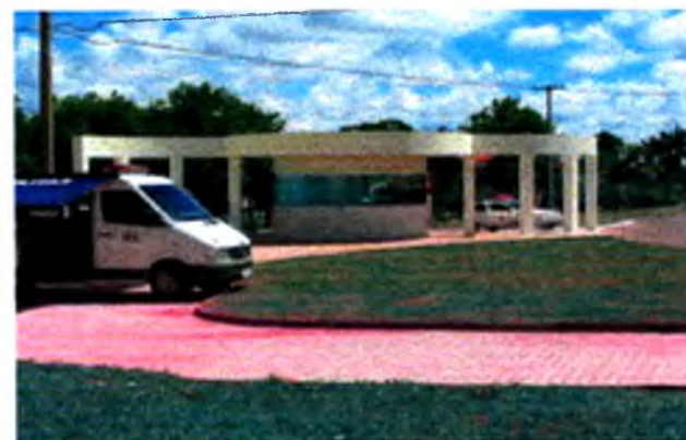
Imagem 34 (acima) Guarita na entrada da Península dos Ministros no Lago Sul
