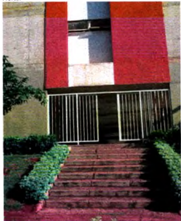
Imagem 35 (acima) Cerca fechando entrada de prédio residencial – 303 Norte
