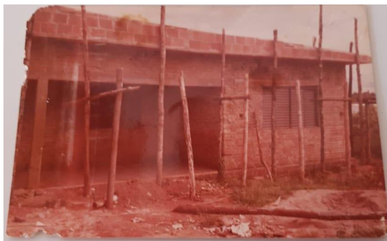
Figura 27 - Casa em construção
