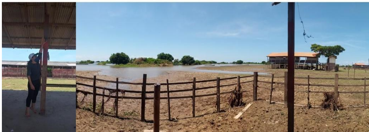
Figura 23: Comunidade Cativo, vazia após a cheia do ano de 2021, com a marca d’água no barracão comunitário em cerca de 2 metros, cercas destruídas pela água e a escola ao fundo, que ficou parcialmente submersa durante o aumento do nível do rio. No momento da foto, as famílias estavam retornando à comunidade.
