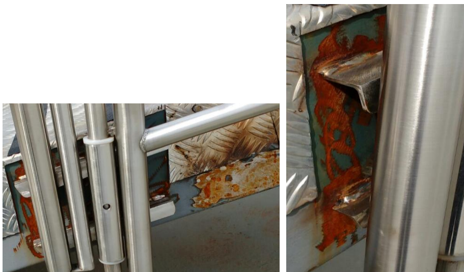
Figuras 16 e 17 - Pontos esmerilhados, lixados e/ou raspados e pontos de solda sem acabamento
