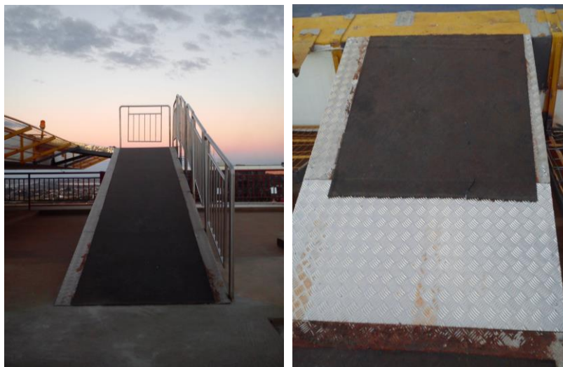
Figura 12: Rampa de acesso ao heliponto - 1ª seção com destaque para a manta emborrachada instalada Figura 13: 2ª seção da rampa de acesso ao heliponto com destaque para a diferença entre as 2 folhas de aço instaladas
