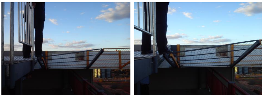
Figuras 8 e 9 - Aplicação de carga na longarina da Grade de Proteção de heliponto e no reforço durante o 2º ensaio
