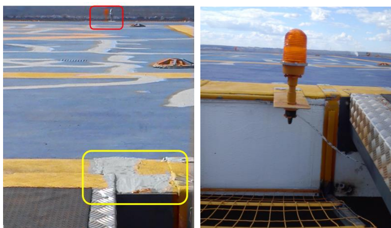
Figura 18 - Áreas destacadas em vermelho e amarelo mostram o alinhamento original das Luzes de Perímetro
