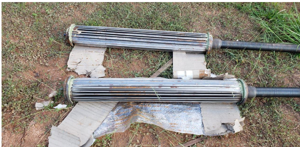
Figura 3.13 Detalhe do sistema expander body instalado na armadura da estaca-teste EB.
