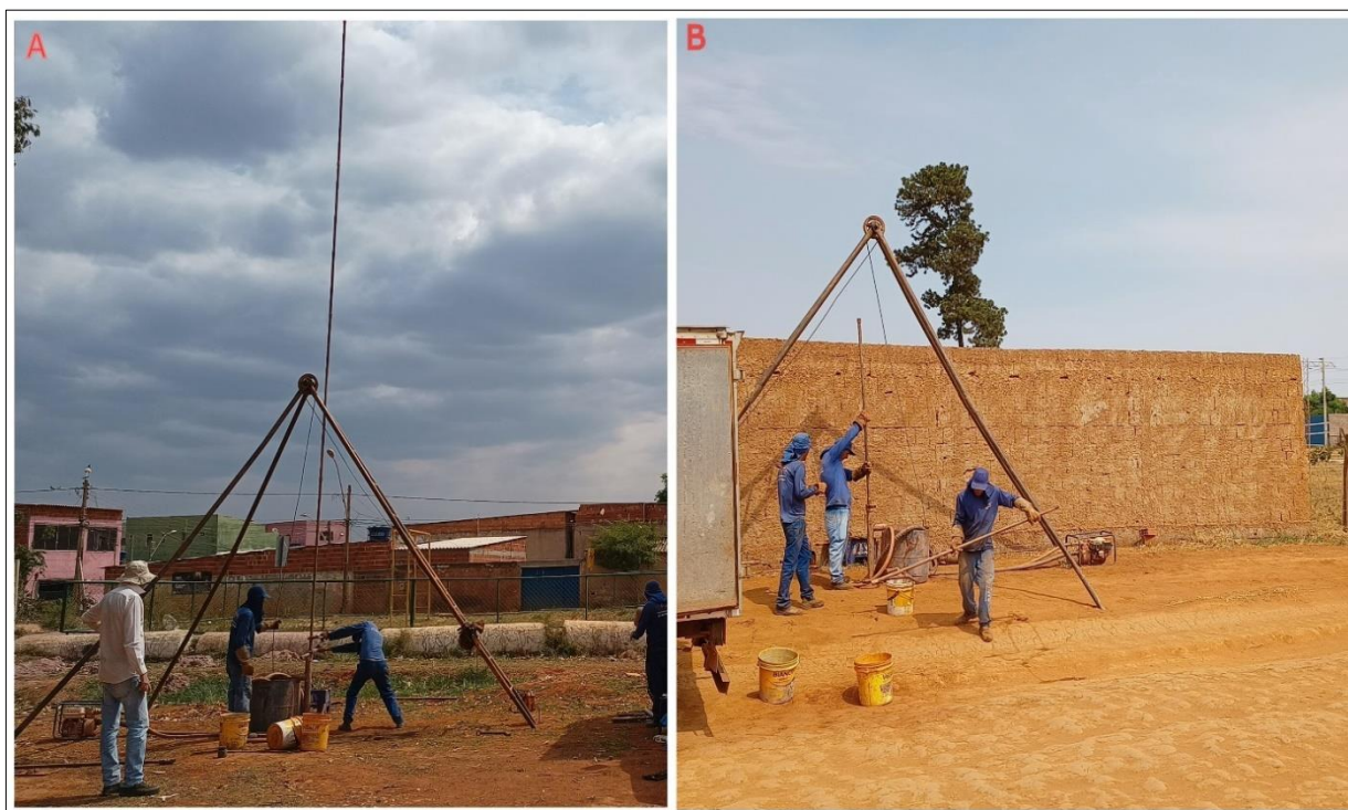
Figura 5.2 - A: SPT01-10572, realizada nas proximidades de uma entrada do Lixão. B: Local de realização das sondagens SPT01 e 02-10573, em área sem contaminação, na Colônia Agrícola 26 de Setembro.
