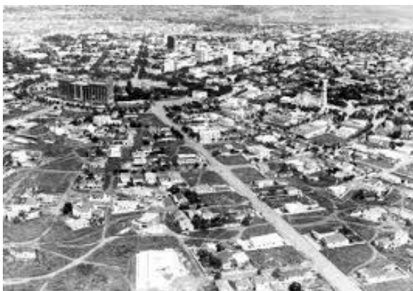
Figura 51 – Implantação das residências junto a Praça Cívica (década de 60) - Centro – Goiânia
