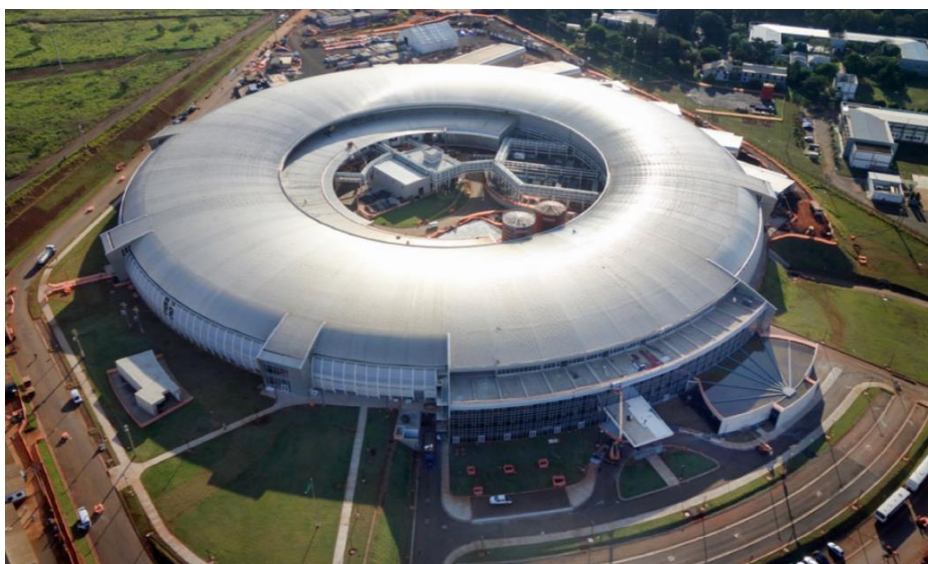
Figura 4.9 Vista panorâmica do Laboratório Nacional de Luz Síncrotron- Sirius. (fonte: Inls.cnpem.br)
