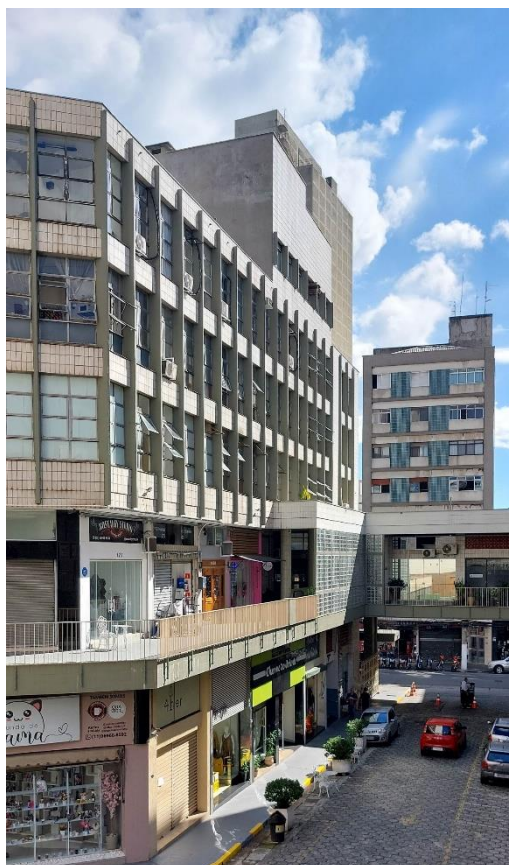
Imagem 58: Vista do vão livre no Shopping Bom Retiro
