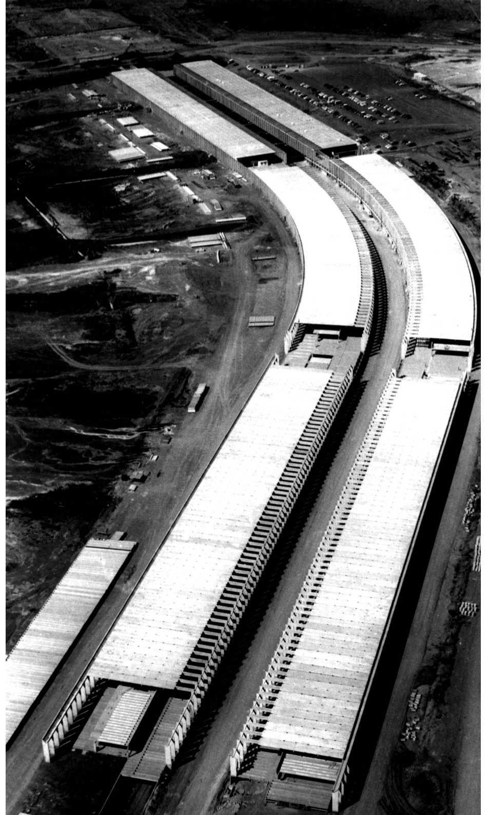
Figura 123: Fotografia aérea da construção do Instituto Central de Ciências (ICC). Fonte: Arquivo Central da Universidade de Brasília.
