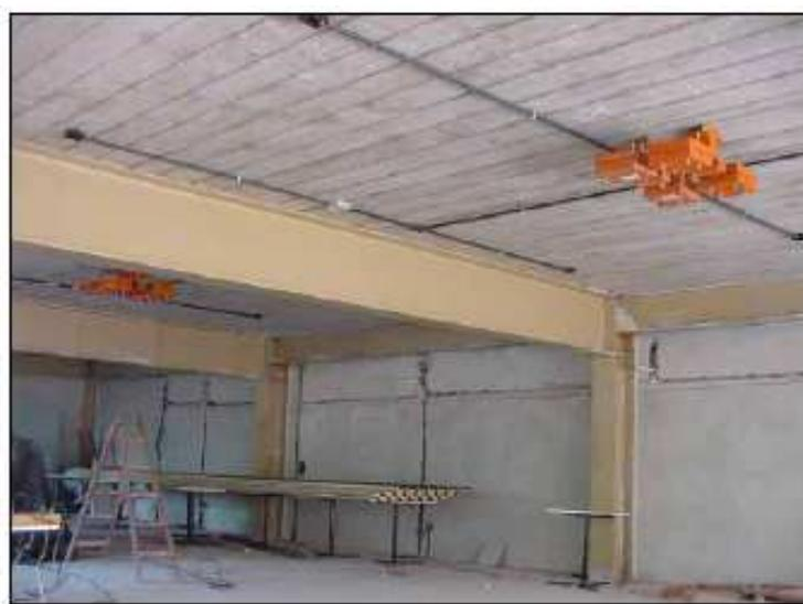
Figura 2.11 – Atenuador Dinâmico Sintonizado instalado (Varela,2004)
