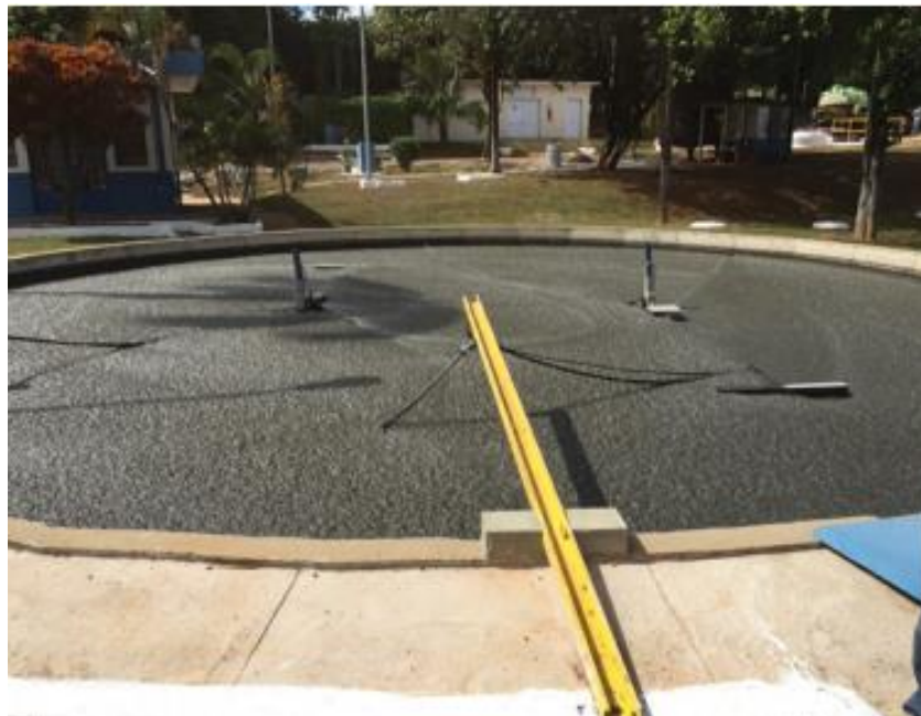
Figura 8 – Estação de Tratamento de Esgoto de Sobradinho
