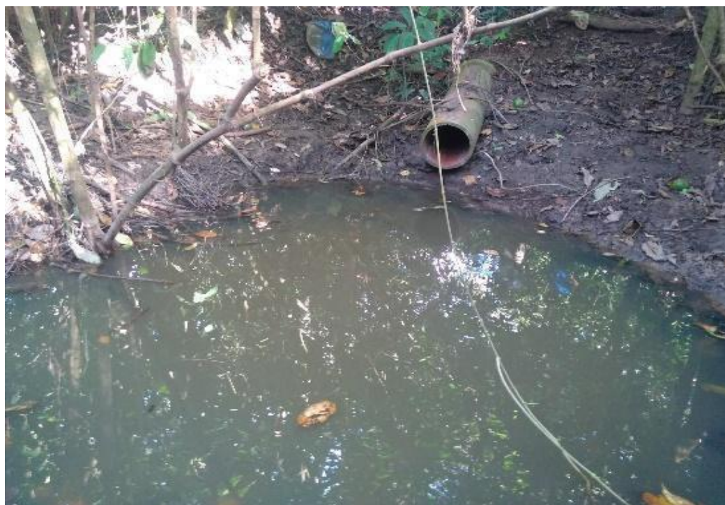
Figura 10 – Despejo de esgoto no Ribeirão Sobradinho, fundo da elevatória da CAESB
