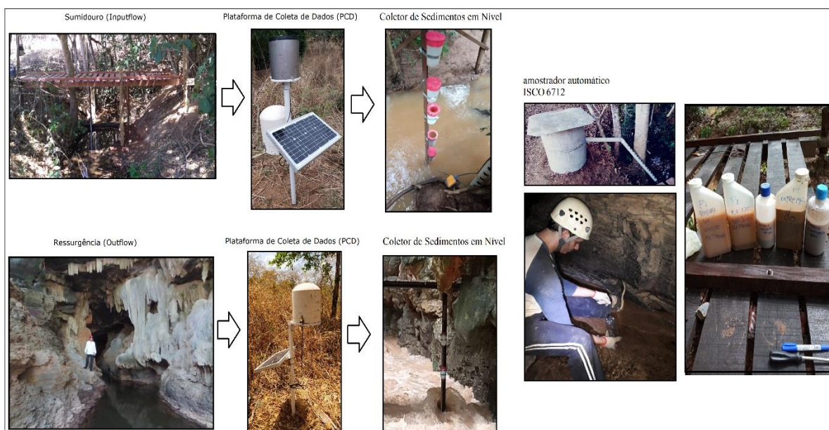
304 305 Figura 6. Instalação dos equipamentos no sumidouro e ressurgência. Fonte: Elaborado 306 pelos autores.
