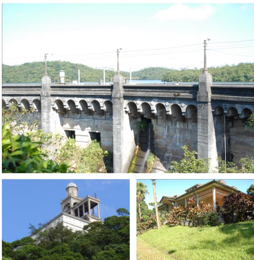
Da esquerda para a direita, Barragem no Alto da Serra, Casa de Válvulas e Casa de Visitas.
