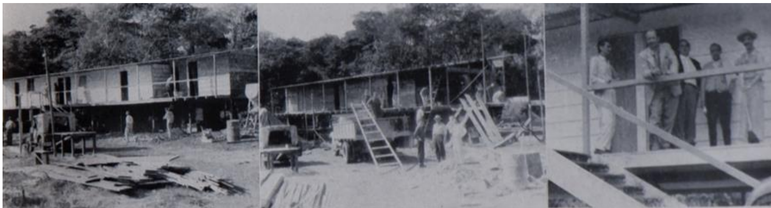
Figura 92. Fotografias da Revista Módulo 6, construção do Palácio Provisório Catetinho, dezembro de 1956. Montagem: Andrey Aspiazu.
