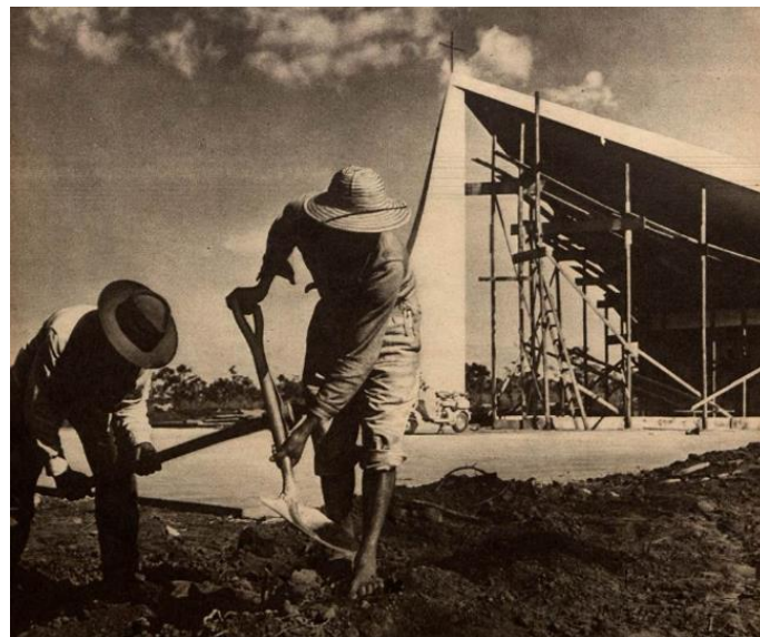
Figura 113. Fotografia de candangos nas obras da Igreja Nossa Senhora de Fátima. Revista Manchete nº 325 de 1958. Fonte: Hemeroteca Digital.
