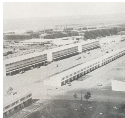
Figura 91. Imagem aérea da W3 Sul. Revista Brasília edição 21 de 1958. Fonte: Arquivo Público do Distrito Federal.
