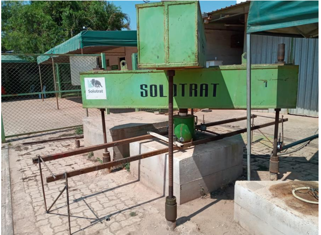
Figura 24. Equipamentos para se realizar a prova de carga do grupo de 4 estacas.
