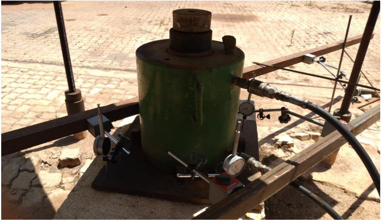
Figura 23. Posicionamento dos deflectômetros para se realizar a prova de carga.
