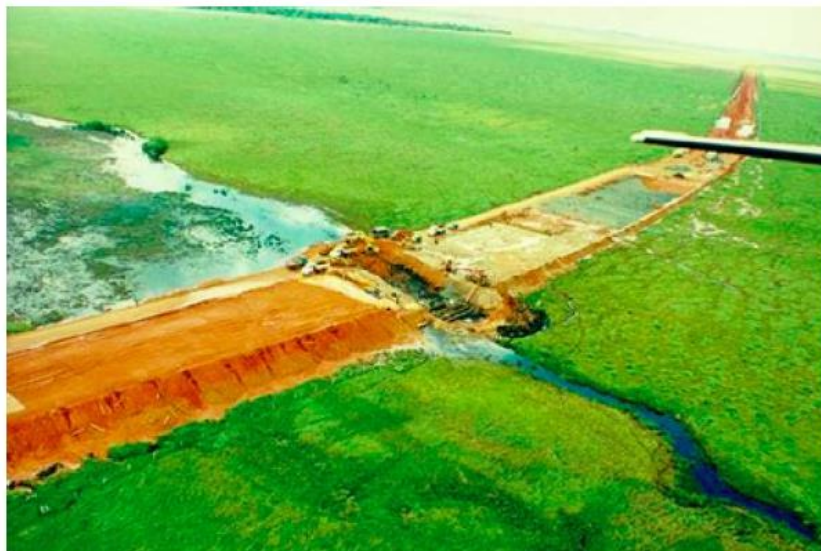
Figura 5. Primeira obra no Brasil utilizando microestaca tubular autoperfurante. Localização: Chapadão do Sul/MS (1999) (Barbosa, 2020).
