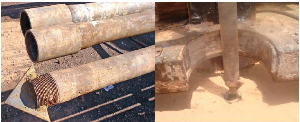
Figura 6. Ponteira da estaca Alluvial Anker e tubos rosqueados (Zuluaga, 2015).
