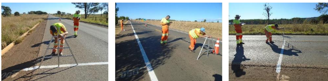
Figura 5.6 – Medição do Afundamento na Trilha de Roda (DNIT)
