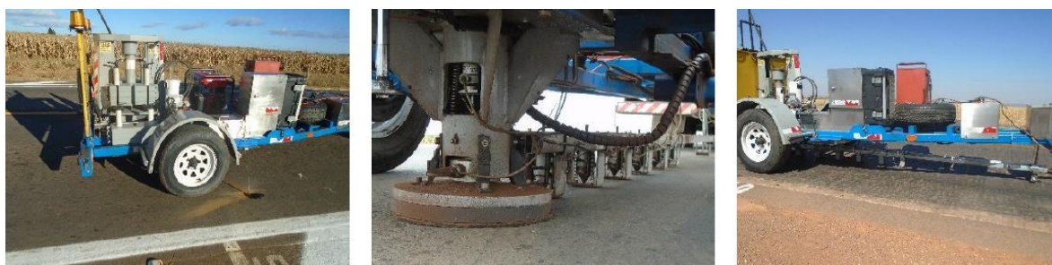
Figura 5.7 – Execução do Levantamento Deflectométrico (DNIT)
