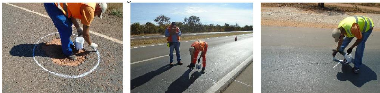
Figura 5.5 – Execução do Levantamento Visual Detalhado (DNIT)
