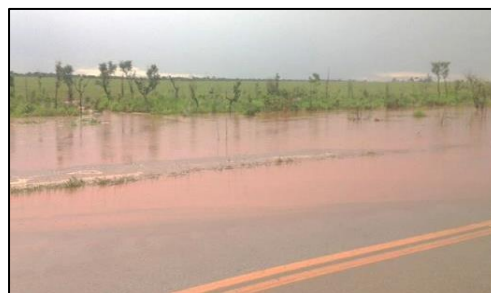
Figura 7 - Ponto de Alagamento na Rodovia DF 140, início do trecho, dezembro de 2021.
