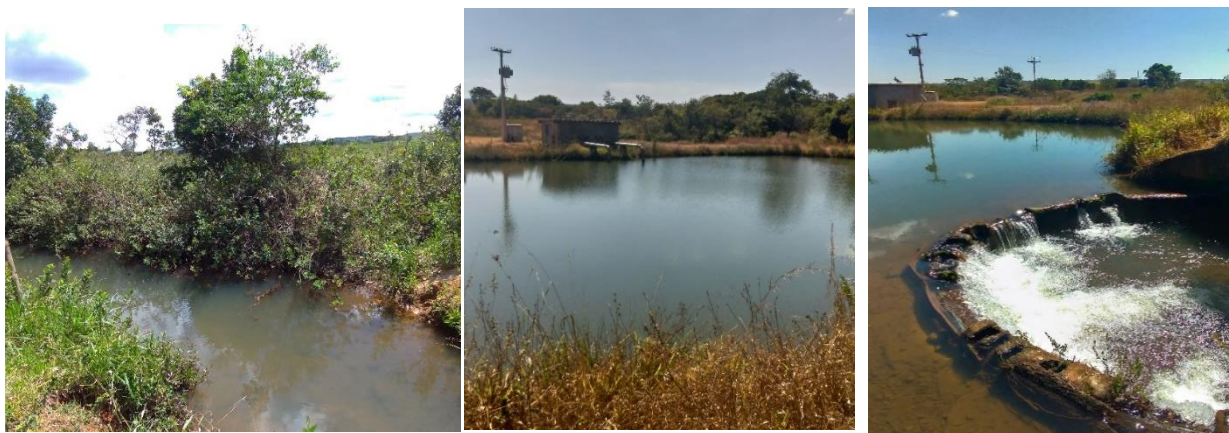
Figura 41 – Registro Fotográfico - Ponto 03 – seção antiga
