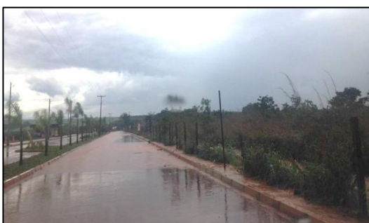
Figura 8 - Ponto de Alagamento no percurso para condomínios do Setor Tororó.
