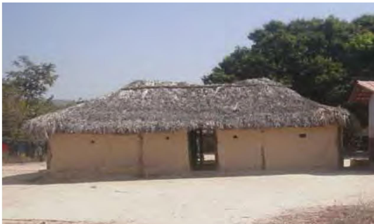
Figura 8 - Casa de adobe Fonte: Jesus, 2011, p. 54.
