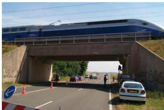
Figura 2.6 – Ponte ferroviária ensaiada experimentalmente. Fonte: Finotti et al. (2019).
