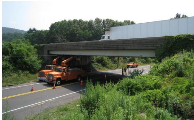
Figura 2.4 – Ponte Meriden, Connecticut, EUA. Fonte: Jin et al. (2015).
