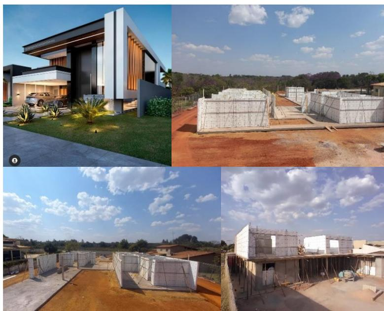
Figura 2.6 – Sistema construtivo que utiliza painéis sanduíche (META CONSTRUTORA EPS, 2018).
