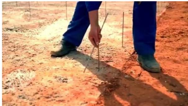
Figura 2.10 – Posicionamento dos arranques (PAREDES BETEL, 2018).
