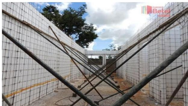
Figura 2.11 – Escoramento dos pré-painéis (PAREDES BETEL, 2018).
