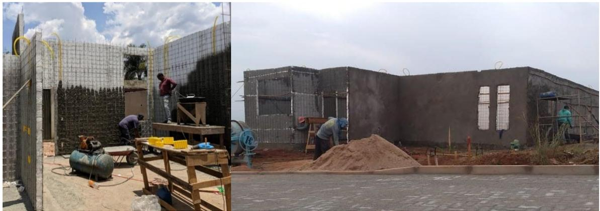
Figura 2.15 – Projeção da argamassa e paredes acabadas (META CONSTRUTORA EPS, 2018).
