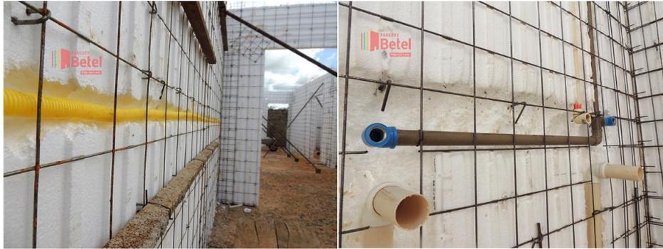
Figura 2.14 – Colocação das instalações elétricas e hidráulicas (PAREDES BETEL, 2018).
