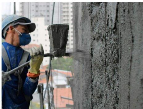
Figura 2.8 – Projeção da argamassa com rebocadora pneumática (ANVI, 2019).
