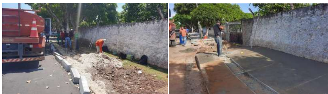
Figura 14: Obras em calçadas da cidade de Macapá
